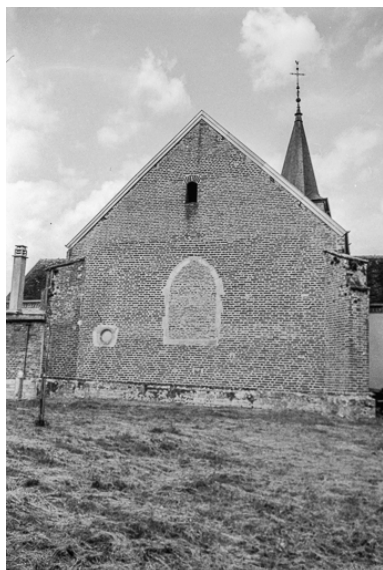
Façade postérieure. Phot. Guy Forestier IVR43_19753900138Z
