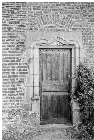
Extérieur : porte latérale. Phot. Guy Forestier IVR43_19753900146Z
