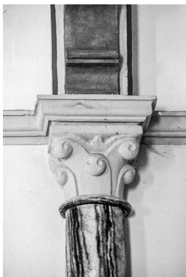
Intérieur : chapiteau. Phot. Guy Forestier IVR43_19753900142Z
