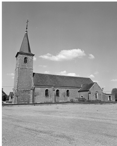
Vue générale. Phot. Bernard Lardière IVR43_19793900290X
