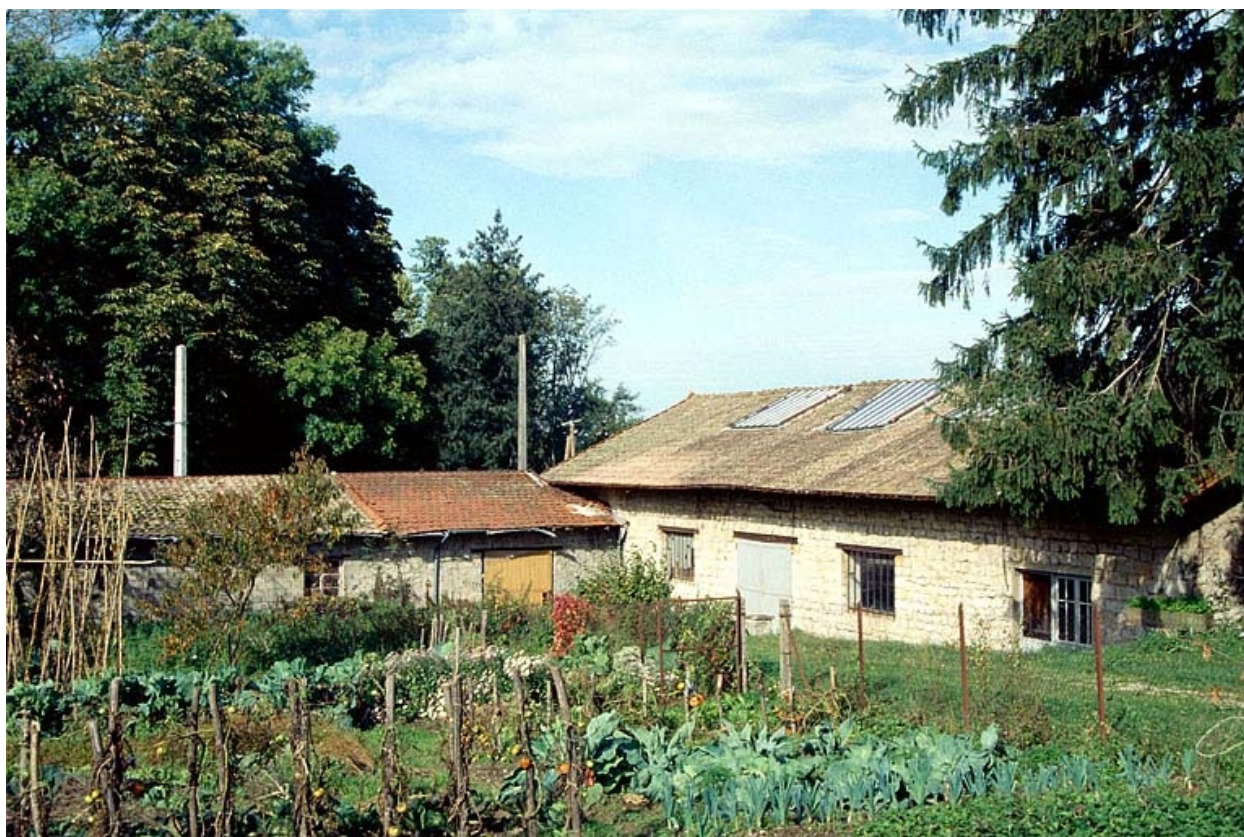
Atelier de fabrication depuis le sud-est.
