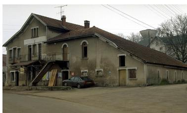
Vue d'ensemble. Phot. Jérôme Mongreville IVR43_19963900075ZA
