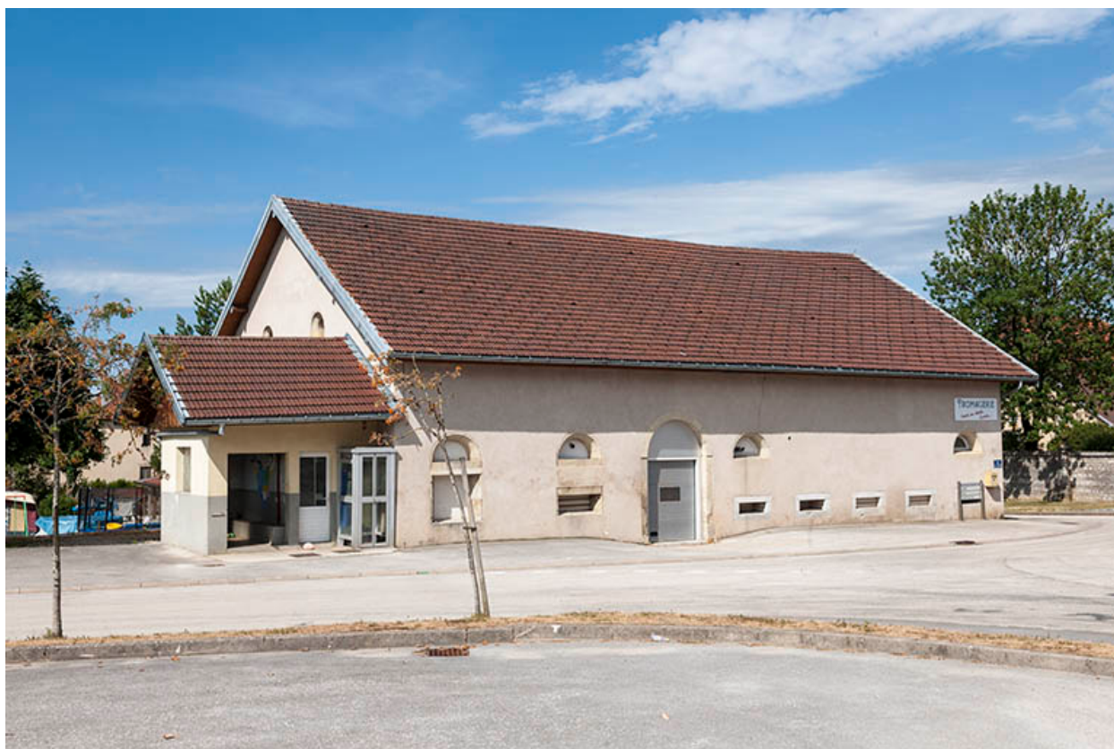
Façade nord en 2015.
