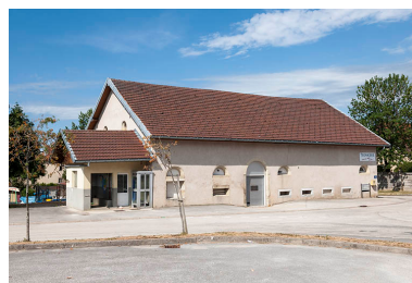
Façade nord en 2015. Phot. Jérôme Mongreville IVR43_20152501646NUC4A
