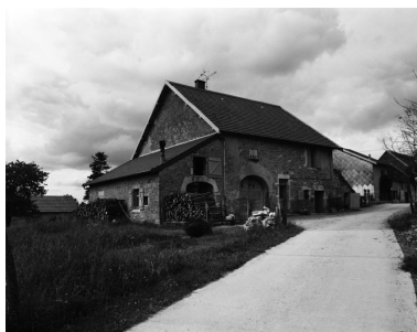
Ferme située rue de la Mare : vue d'ensemble. Phot. Yves Sancey IVR43_19813900263X
