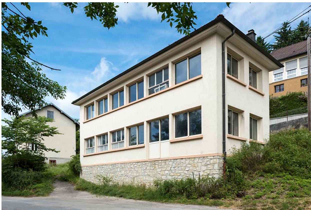
Façades postérieure et latérale gauche.
