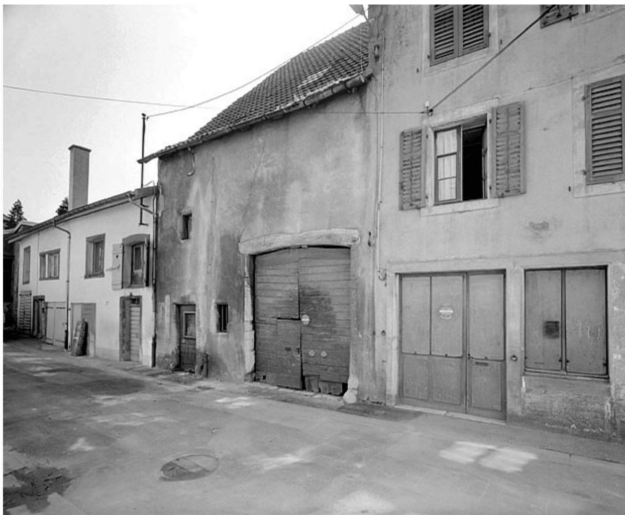
Façade sur l'impasse.
