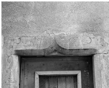
Date sur le linteau de la porte piétonne. Phot. Jérôme Mongreville IVR43_19882500100X
