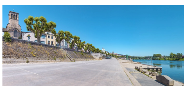
Quai sud, au pied de l'église Sainte-Madeleine. Phot. Thierry Kuntz IVR26_20217100465NUC4A
