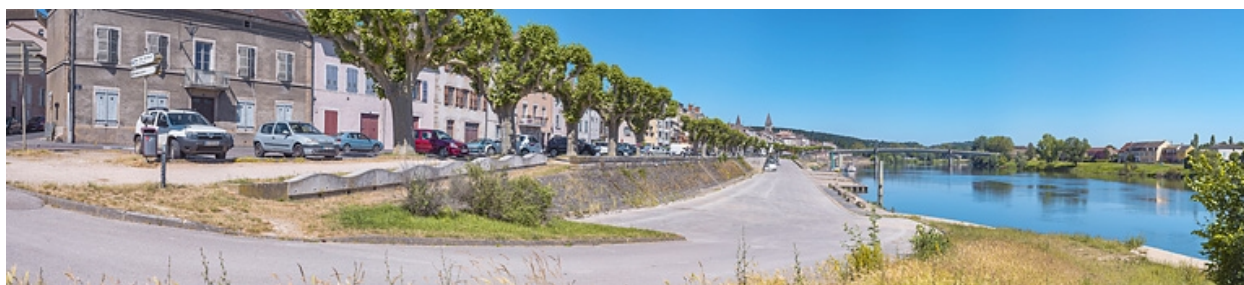
Vue d'ensemble du quai sud.
