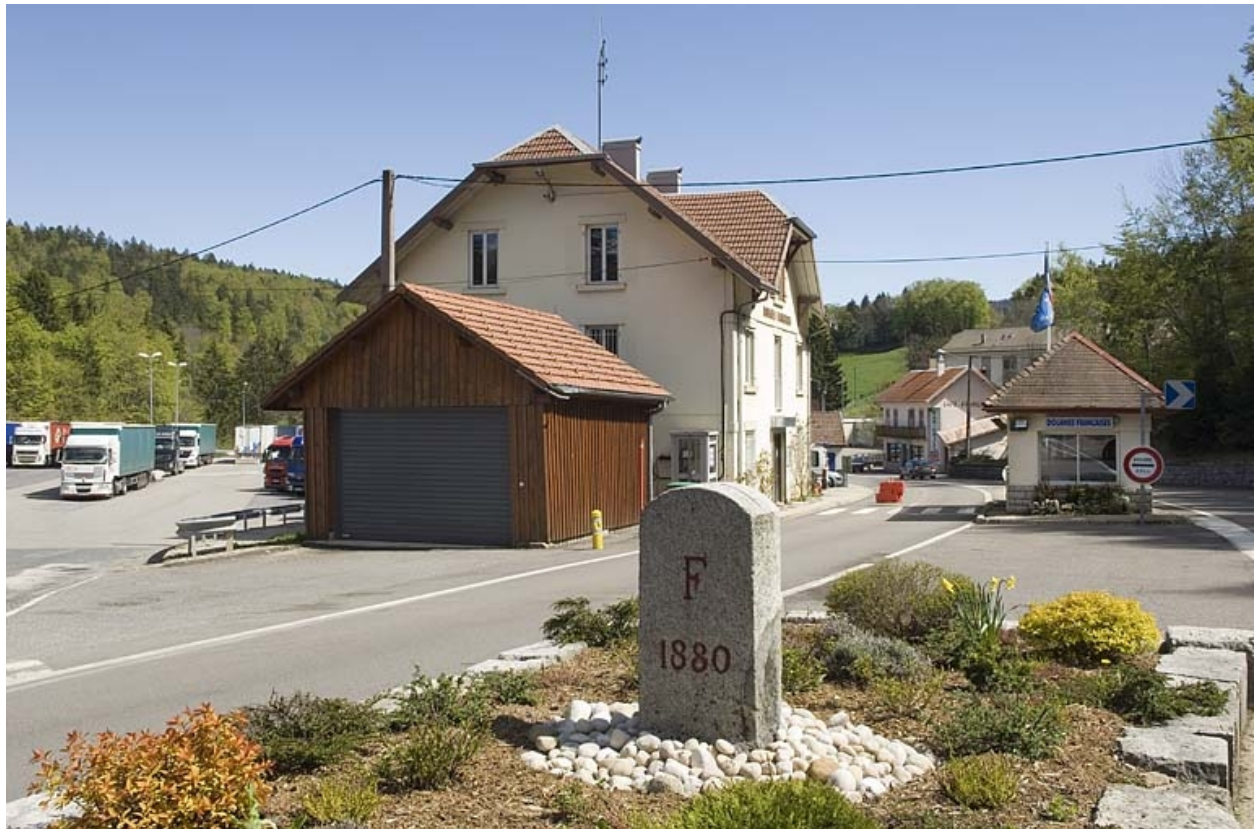
Vue d'ensemble des bâtiments de la douane.
