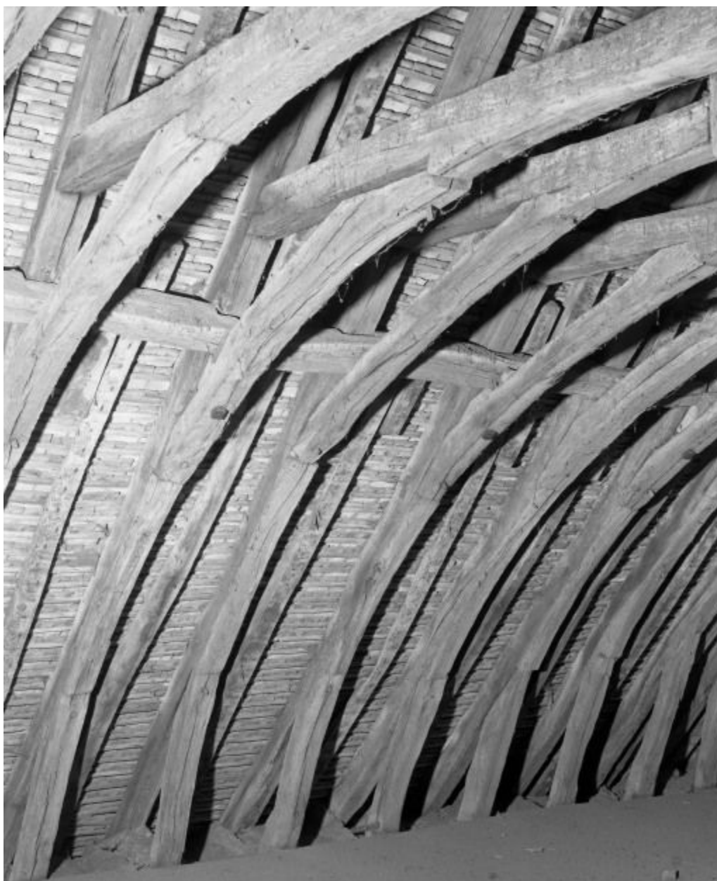
Charpente du comble
