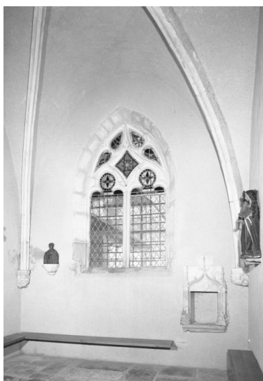
Chapelle seigneuriale, mur postérieur Phot. Jean-Luc Duthu IVR26_19852101138V
