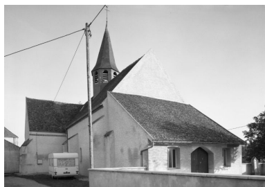
Elévations antérieure et gauche Phot. Jean-Luc Duthu IVR26_19852101131V
