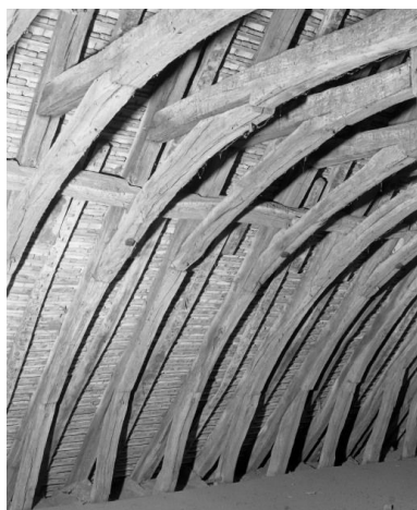
Charpente du comble Phot. Michel Thierry IVR26_19852101219X
