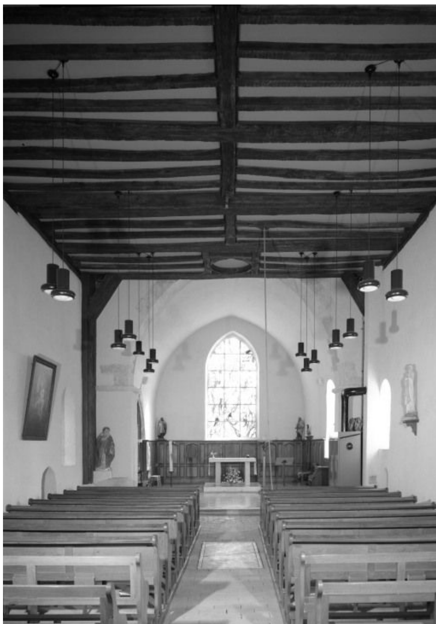
Vue intérieure prise de l'entrée
