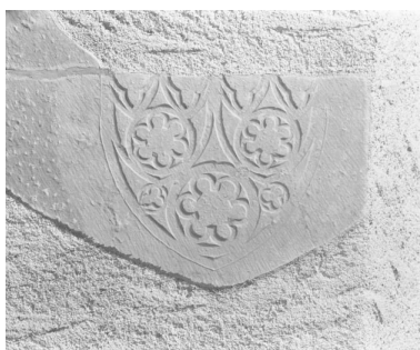
Elévation droite, linteau de la porte murée du choeur Phot. Michel Thierry IVR26_19852101134X
