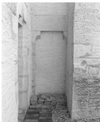
Elévation gauche, porte murée du choeur et porte de la chapelle Phot. Michel Thierry IVR26_19852101132X
