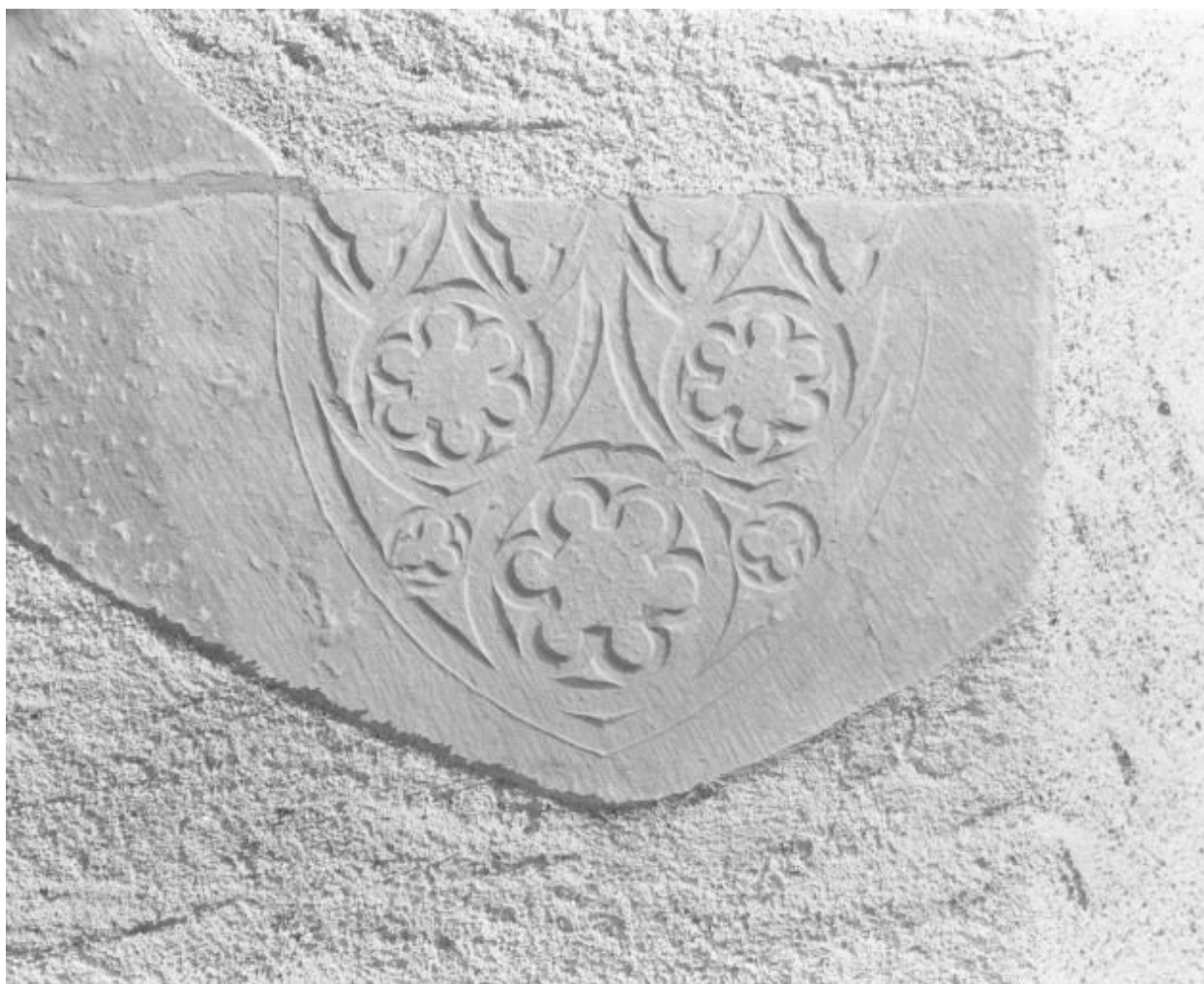
Elévation droite, linteau de la porte murée du chœur
