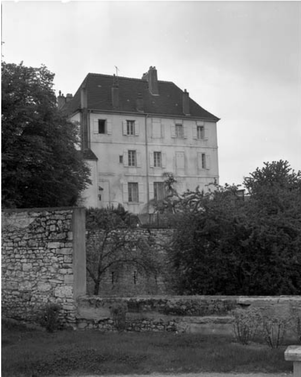
Façade latérale du bâtiment principal.
