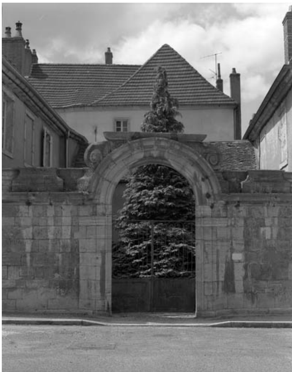
Portail d'entrée droit, depuis la place.
