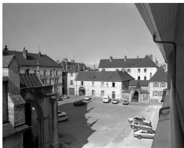
Façade antérieure sur rue : vue d'ensemble.
