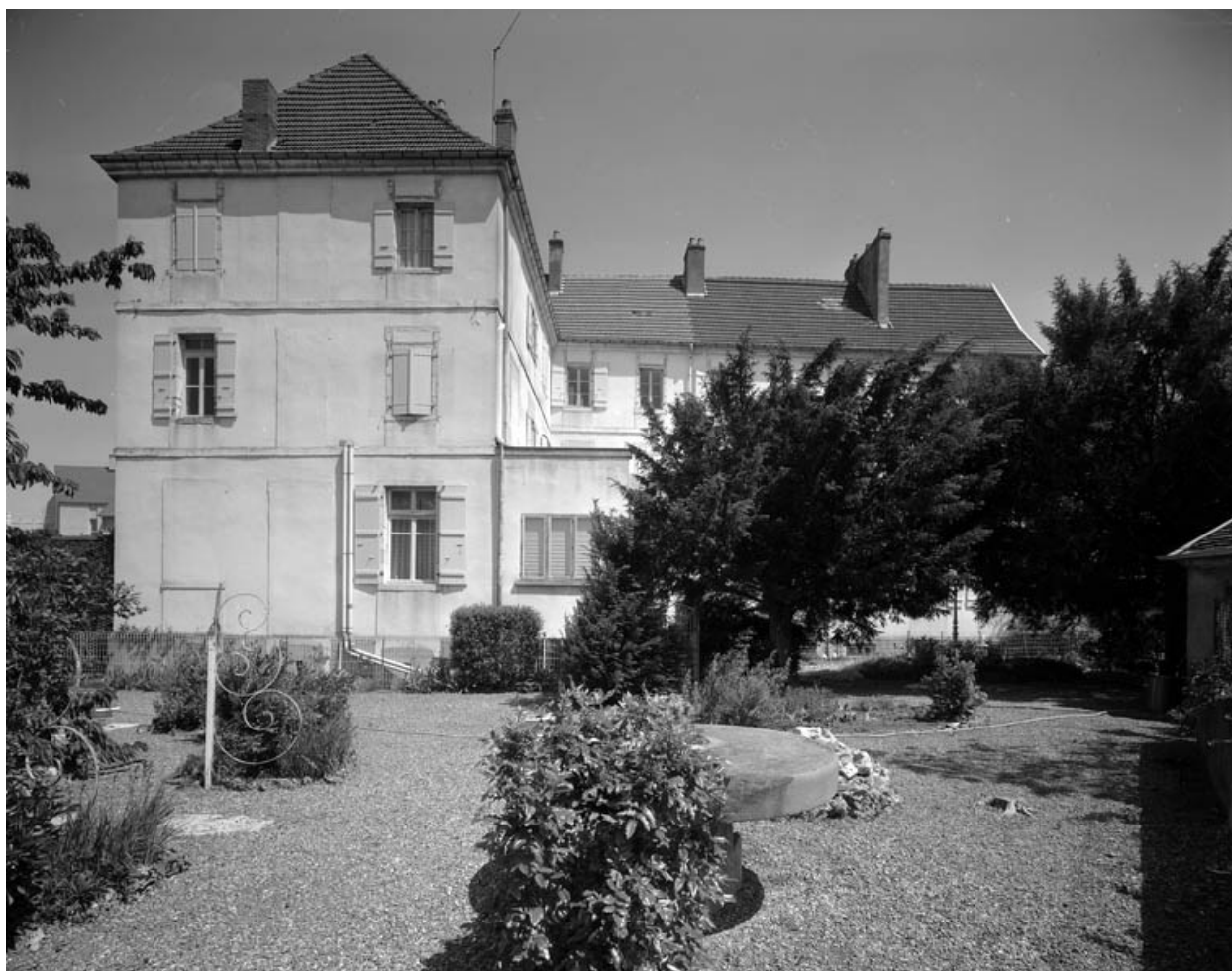
Façade postérieure du bâtiment principal : de face.
