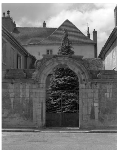
Portail d'entrée droit, depuis la place.
