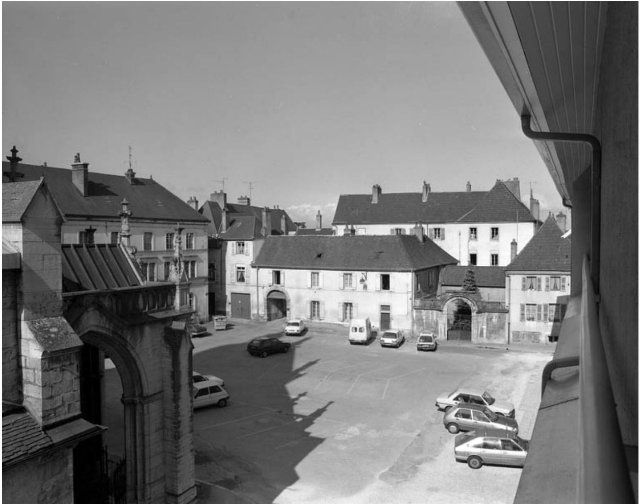
Façade antérieure sur rue : vue d'ensemble.
