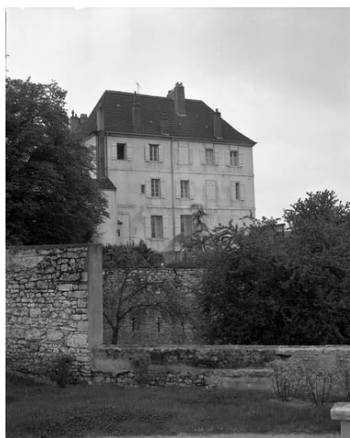
Façade latérale du bâtiment principal. Phot. Yves Sancey IVR43_19917000126X
