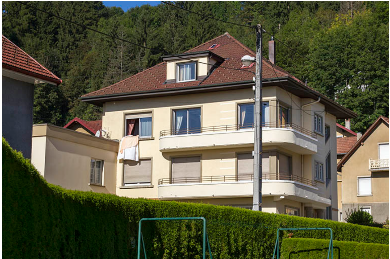
Façades postérieure et latérale gauche.
