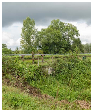
Vue rapprochée de l'ouvrage. Phot. Pierre-Marie Barbe-Richaud IVR26_20177100289NUC2A
