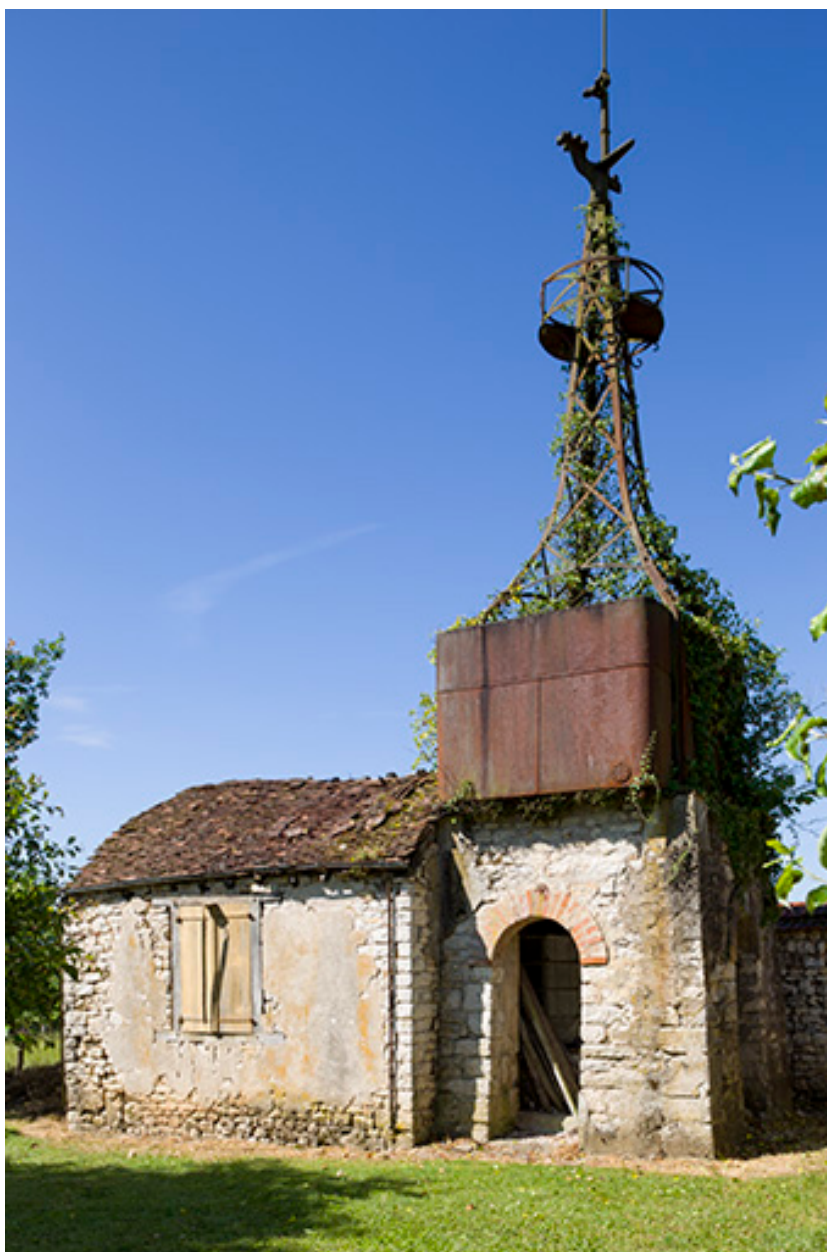
Vue rapprochée du bâtiment et de l'éolienne.
