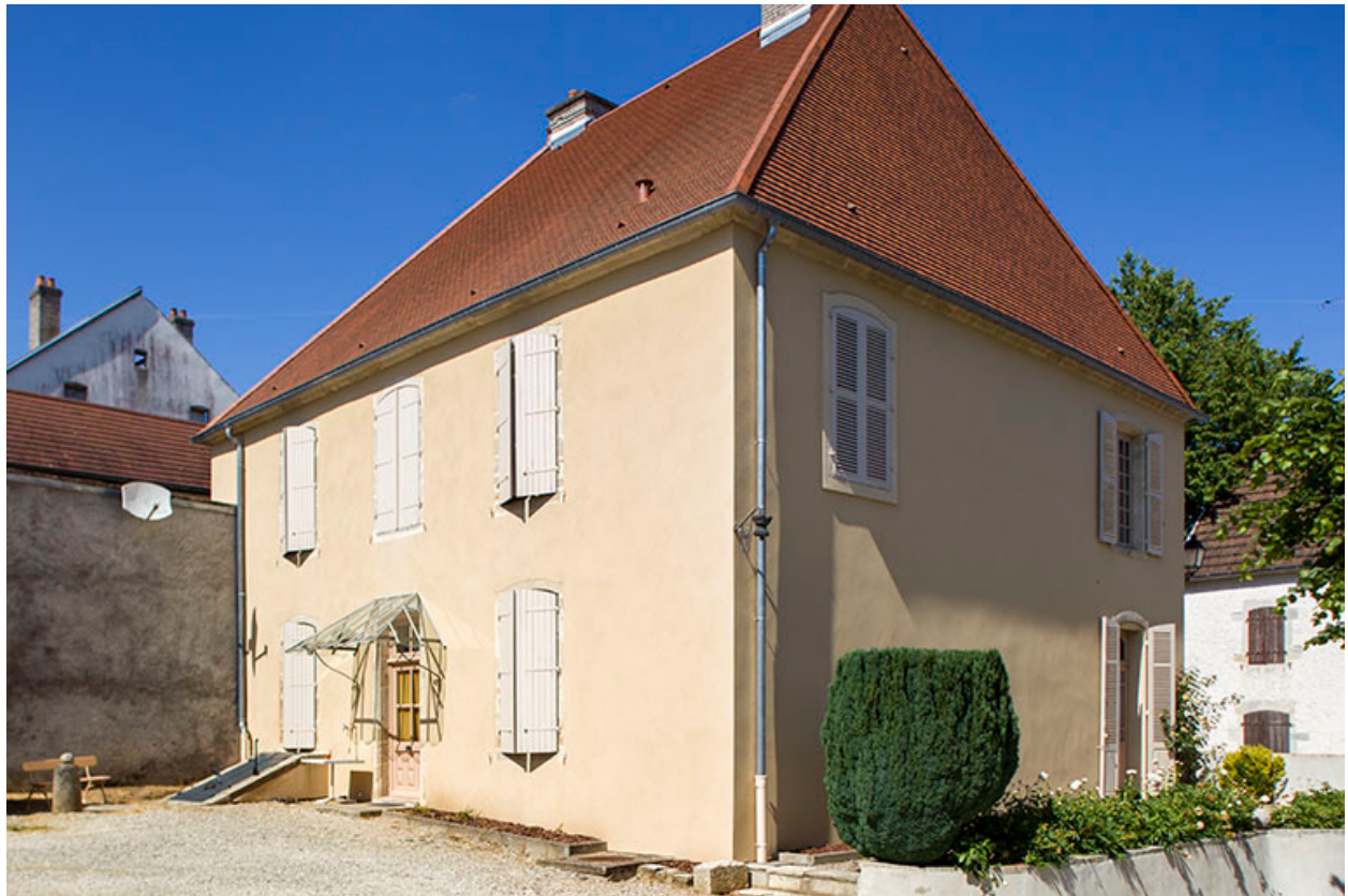
Façade postérieure de trois quart gauche.
