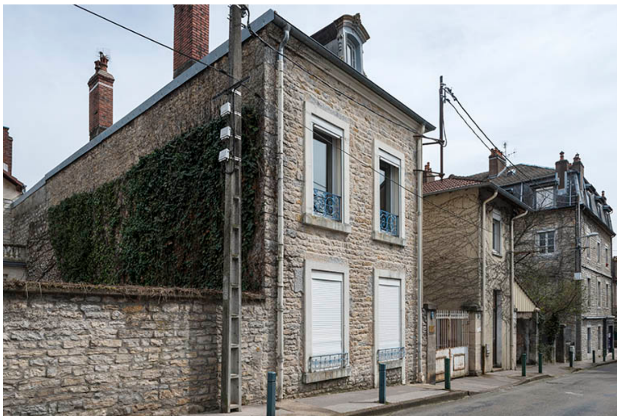
Entrée rue du Château-Rose.
