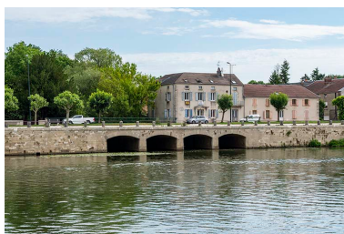
Vue de trois-quarts gauche. Phot. Jérôme Mongreville IVR43_20197000384NUC4A
