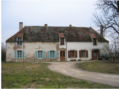
Vue d'ensemble de la façade.
