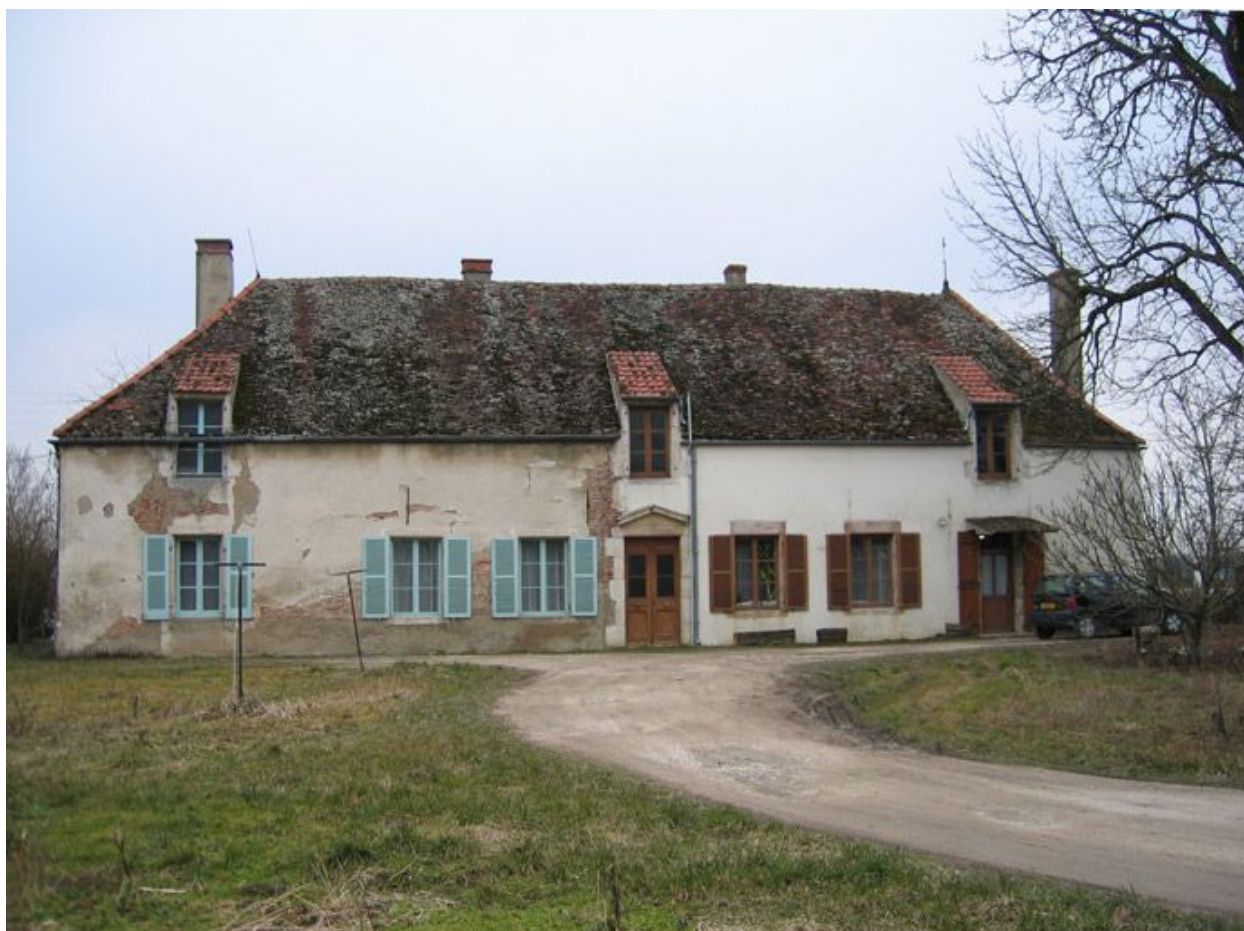
Vue d'ensemble de la façade.
