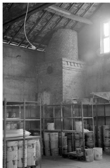
Vestige de la cheminée d'usine. Phot. Laurent Poupard IVR43_19893900241Z
