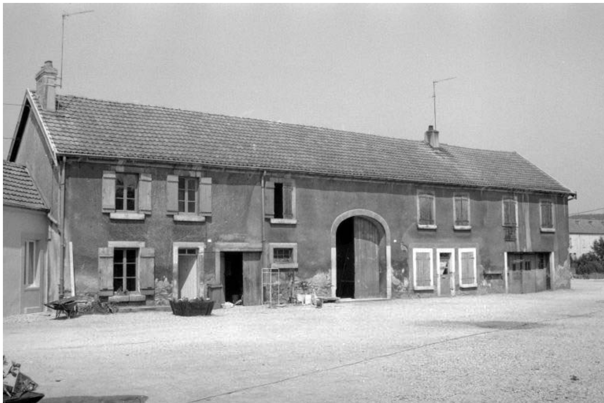
Logement d'ouvriers, écuries et fenil (C).
