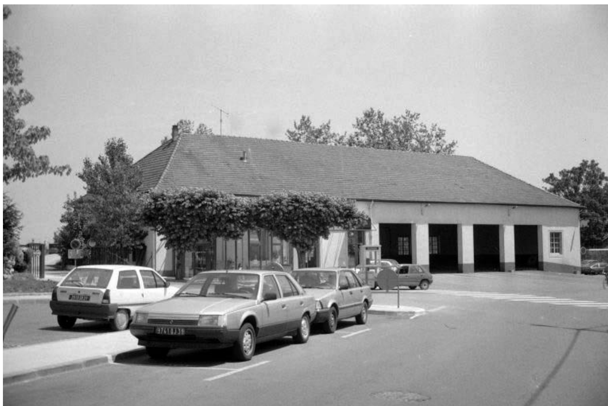
Vue d'ensemble depuis le jardin, au nord.
