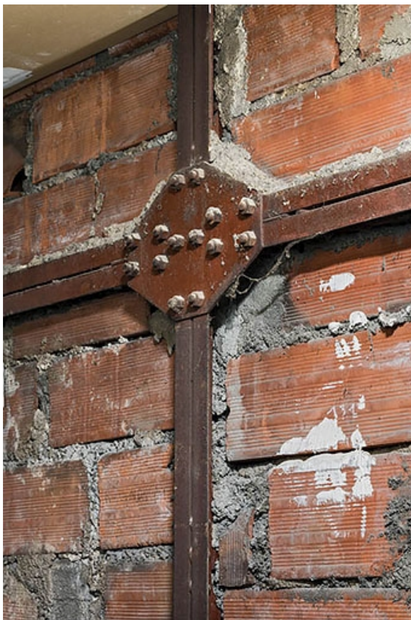
Détail du pan de fer d'un mur.
