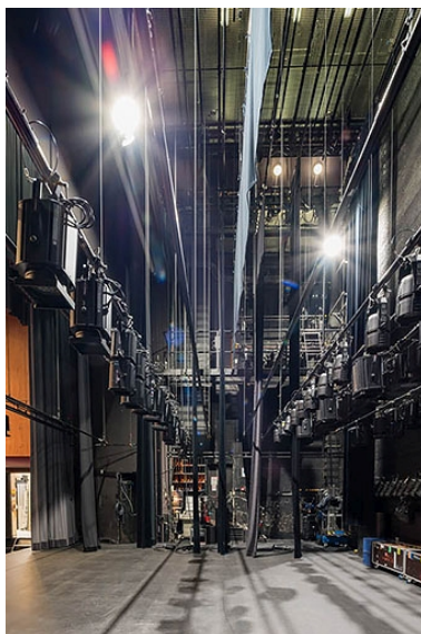
Cage de scène : perches avec projecteurs (vue latérale). Phot. Pierre-Marie Barbe-Richaud IVR26_20212100254NUC4A
