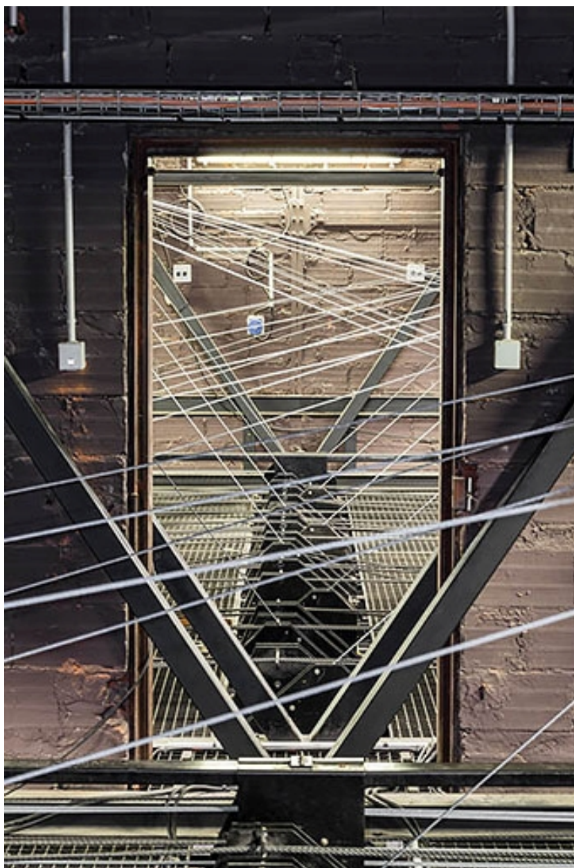
Cage de scène : grill (cadrage vertical).
