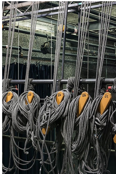
Cage de scène : fils enroulés sur des palets (taquets).
