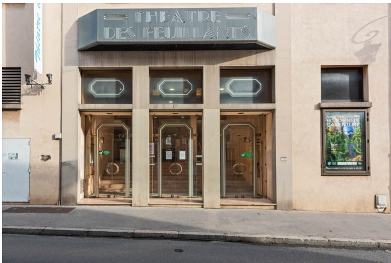
Façade antérieure : entrée.
