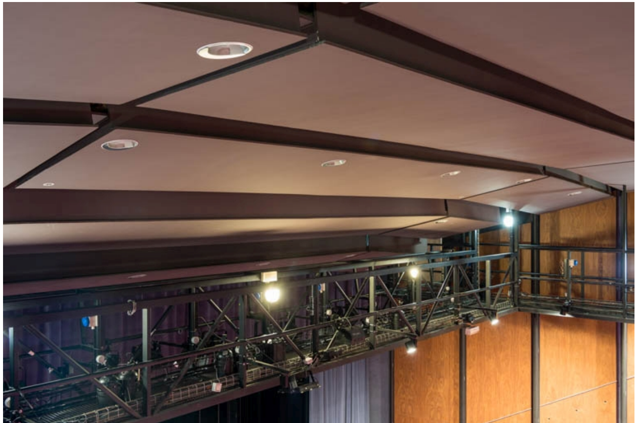
Salle : passerelle et plafond abat-son.
