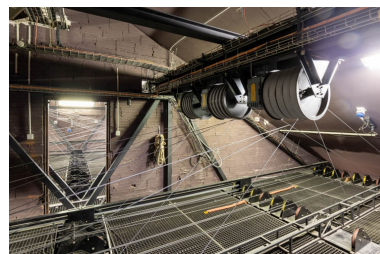
Cage de scène : grill. Phot. Pierre-Marie Barbe-Richaud IVR26_20212100258NUC4A
