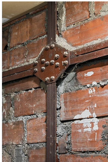
Détail du pan de fer d'un mur. Phot. Pierre-Marie Barbe-Richaud IVR26_20212100260NUC4A
