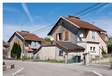
Maisons jumelées rue des Salines. Phot. Jérôme Mongreville IVR43_20152501106NUC4A
