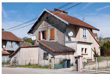
Maison jumelée vue de trois quarts. Phot. Jérôme Mongreville IVR43_20152501107NUC4A
