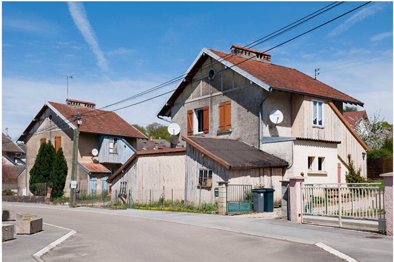
Maisons jumelées rue des Salines.
