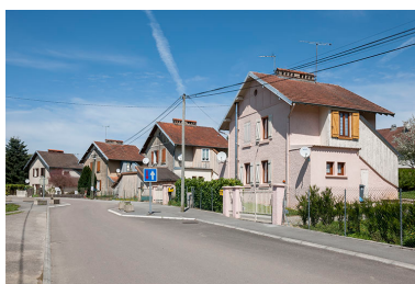
Alignement de maisons jumelées (rue des Salines). Phot. Jérôme Mongreville IVR43_20152501105NUC4A
