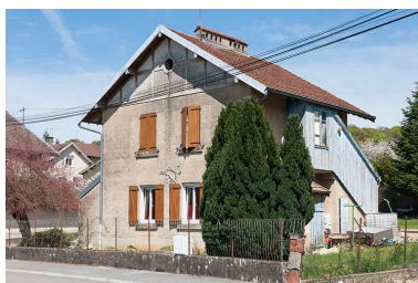
Maison jumelée (21 rue des Salines). Phot. Jérôme Mongreville IVR43_20152501108NUC4A
