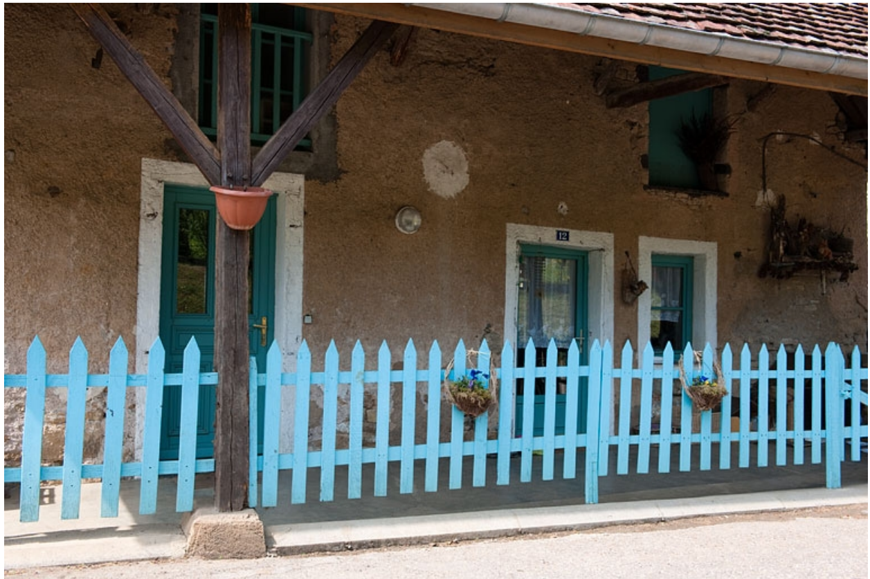
Façade antérieure, vue rapprochée.
