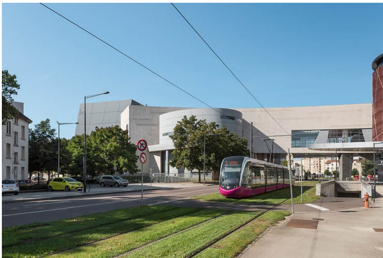
Salle de concert dite l'Auditorium (11 boulevard de Verdun).
