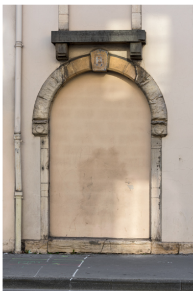
Cinéma Devosge, façade antérieure : porte murée. Phot. Pierre-Marie Barbe-Richaud IVR26_20232100009NUC4A
