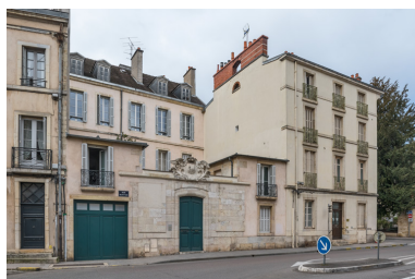
Tripot des Barres ou ancienne Comédie (8 rue Buffon) : vue d'ensemble dans la rue. Phot. Pierre-Marie Barbe-Richaud IVR26_20232100006NUC4A
