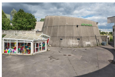
Salle de spectacle l'Atheneum (6 boulevard Gabriel). Phot. Pierre-Marie Barbe-Richaud IVR26_20212100072NUC4A
