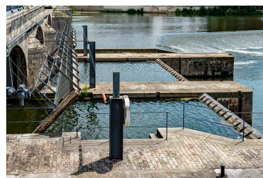
La partie mobile du barrage de Gray. Phot. Jérôme Mongreville IVR43_20207000226NUC4A
