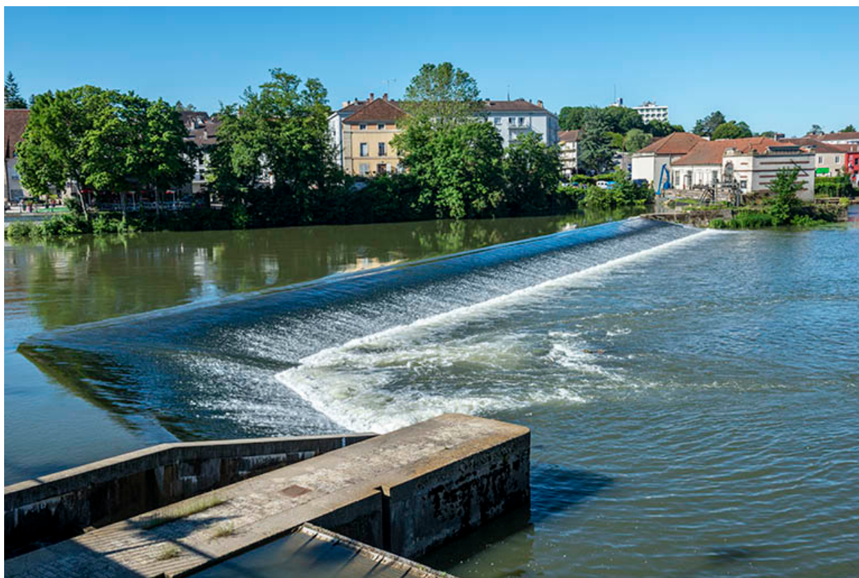
Vue générale depuis la rive droite.
