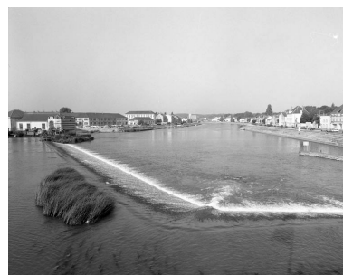
Vue générale du barrage depuis le pont. Phot. Yves Sancey IVR43_19887000050X
