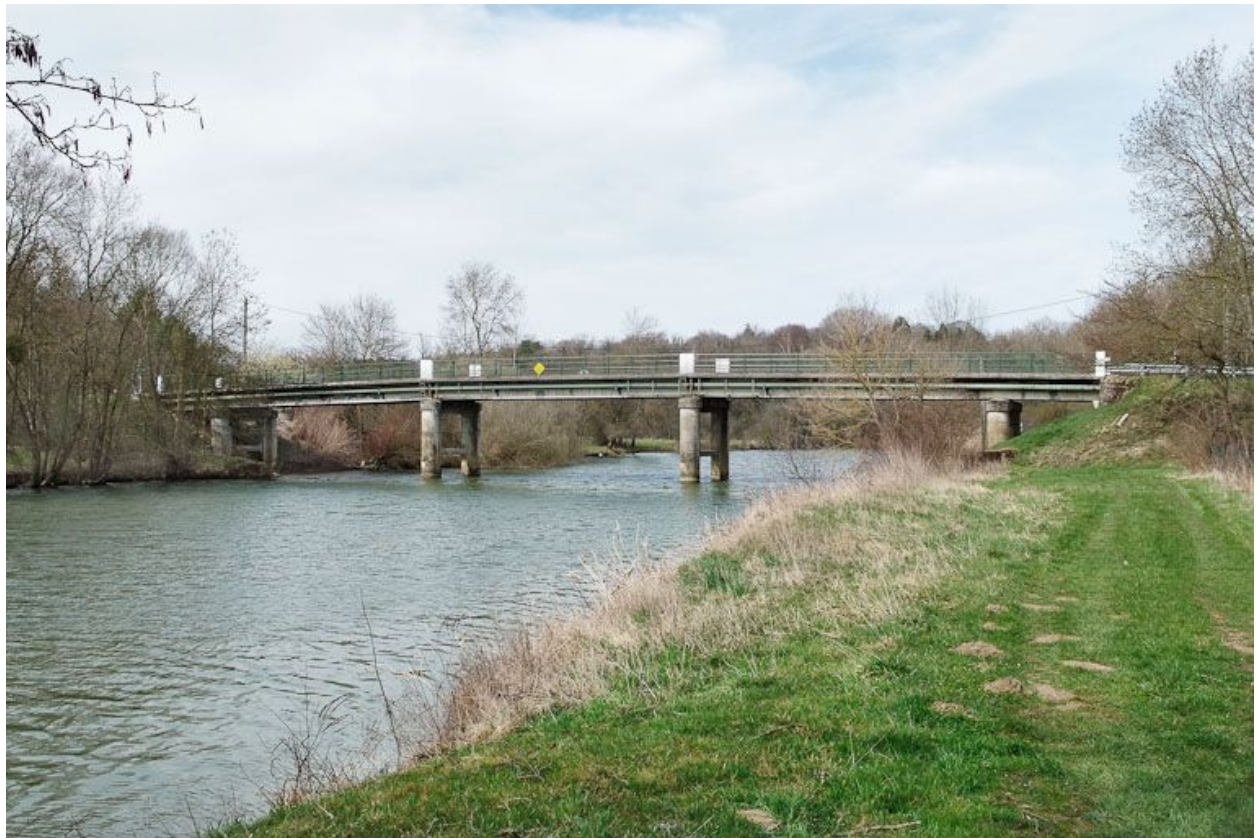
Vue d'ensemble du pont de Chevreuse à Rancy.
