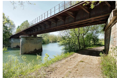
Pont de chemin de fer de Ratenelle, désaffecté, vu du dessous. Phot. Jean-Luc Duthu IVR26_20107100540NUC2A
