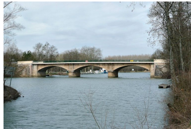
Le pont de Cuisery, vue d'amont. Phot. Jean-Luc Duthu IVR26_20107100394NUC2A
