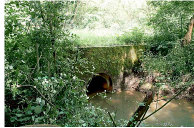
Vue d'ensemble d'un ponceau à Rancy. Phot. Jean-Luc Duthu IVR26_20107100330NUC2A
