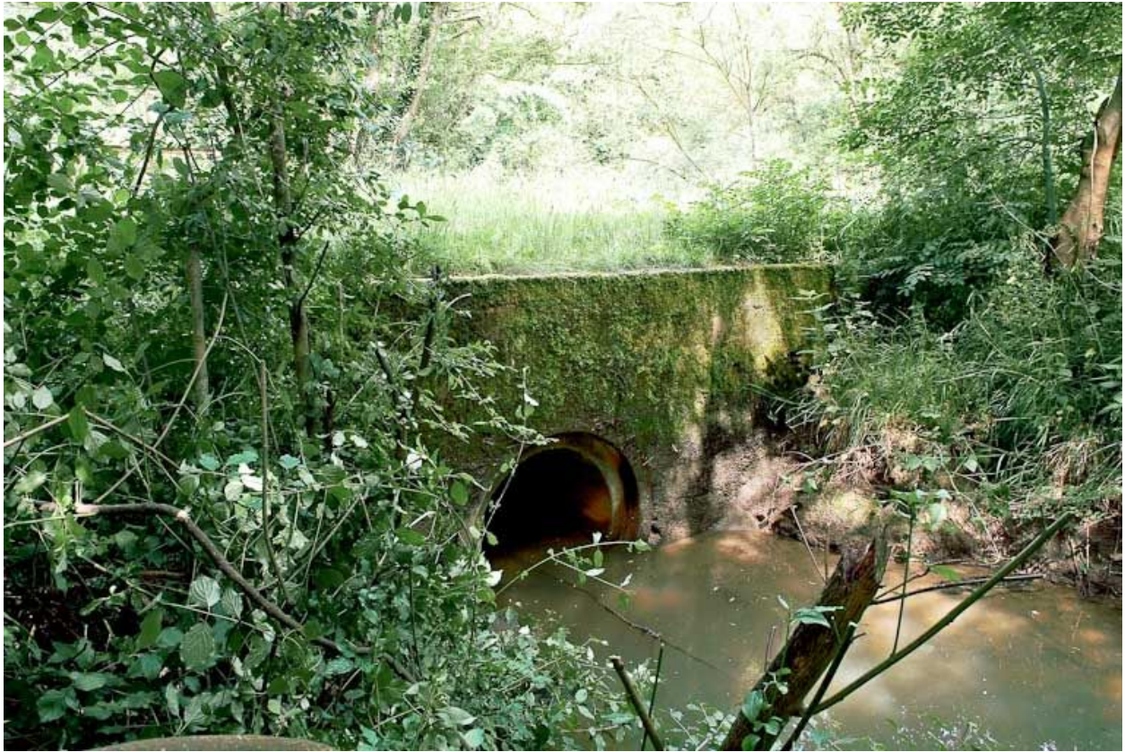
Vue d'ensemble d'un ponceau à Rancy.
