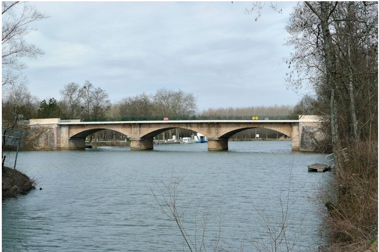
Le pont de Cuisery, vue d'amont.
