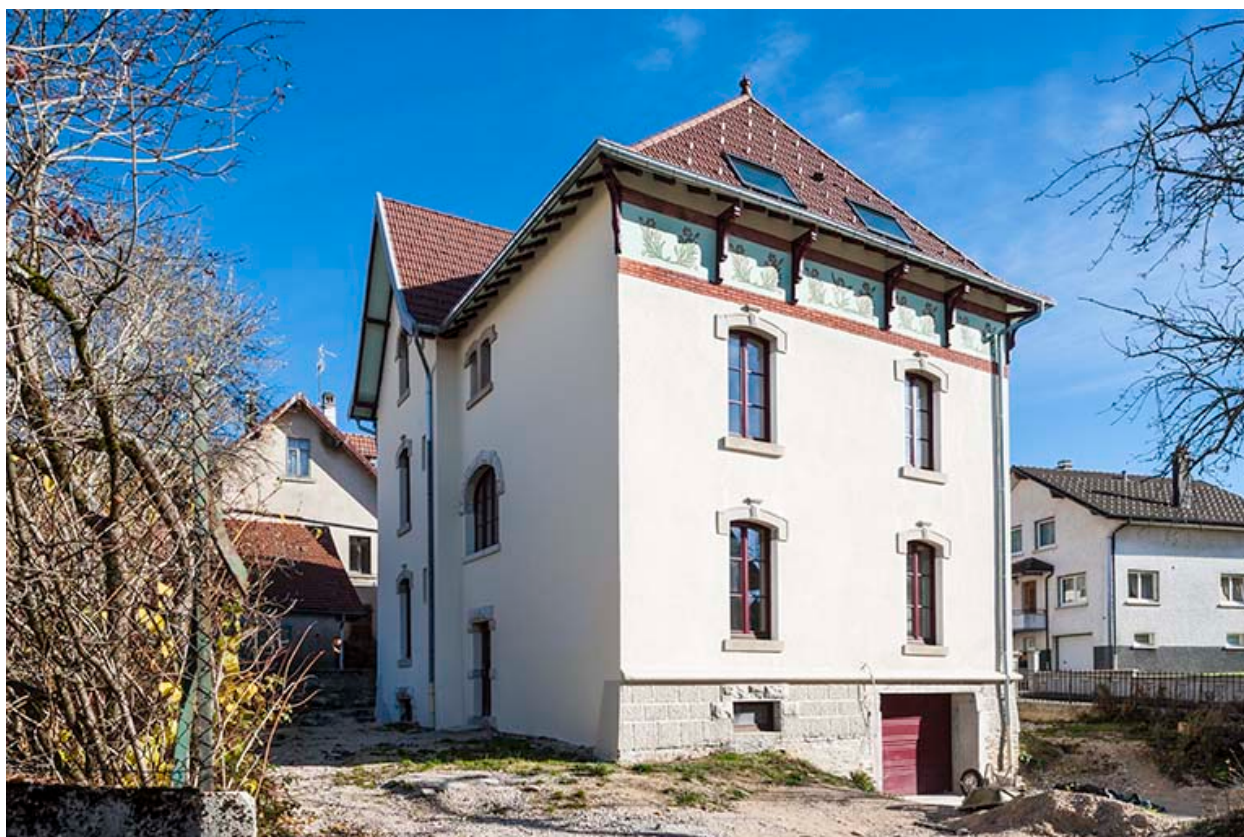
Maison : façades postérieure et latérale gauche.
