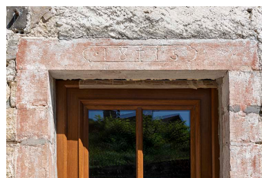
Bâtiment au n° 3 : linteau daté 1815. Phot. Sonia Dourlot IVR43_20192501187NUC4A
