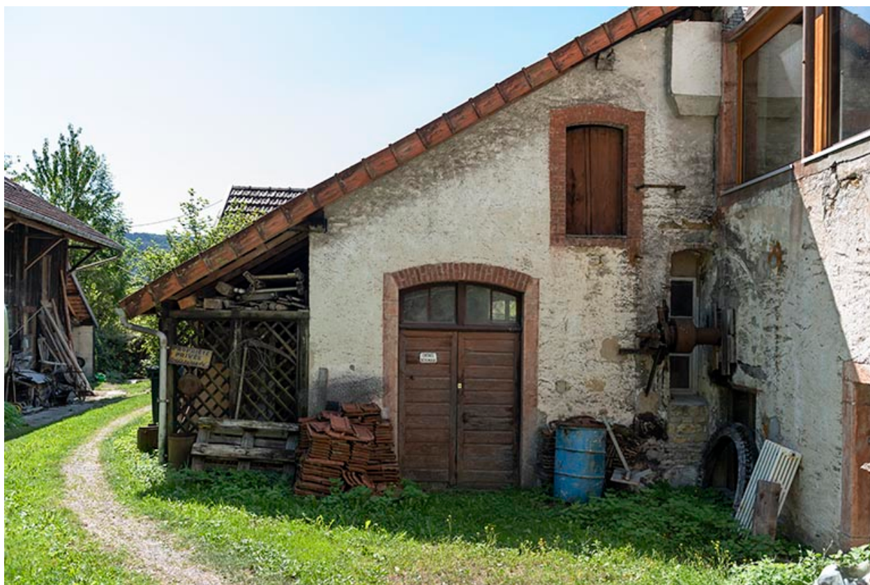
Bâtiment d'eau : façade antérieure.
