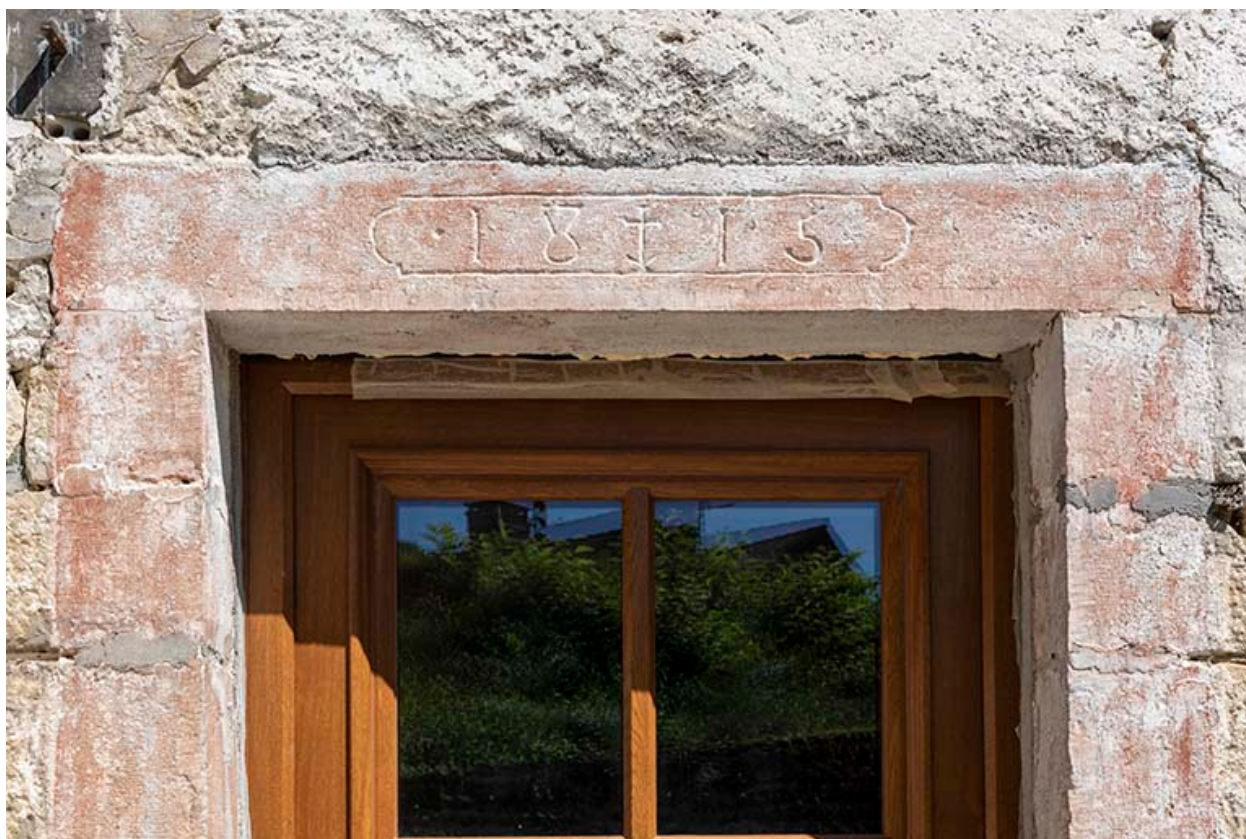
Bâtiment au n° 3 : linteau daté 1815.
