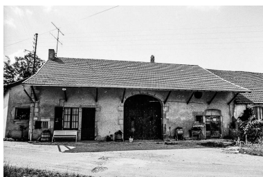
Maison cadastrée 1960 AR 104, située au lieu- dit Bard : façade antérieure. Phot. Bernard Pontefract IVR43_19753900450Z
