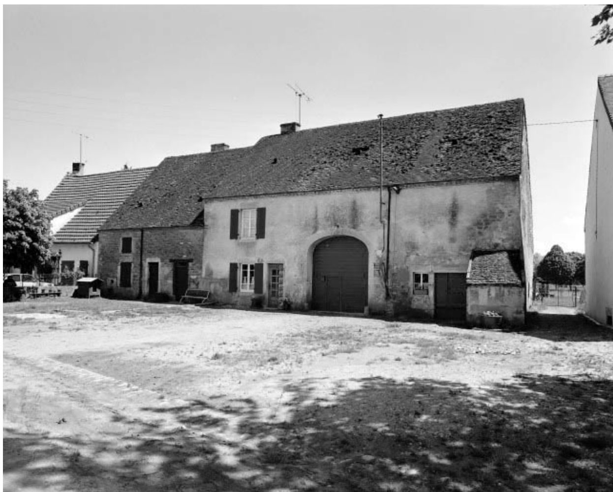
Ferme située rue Neuve : façade antérieure.
