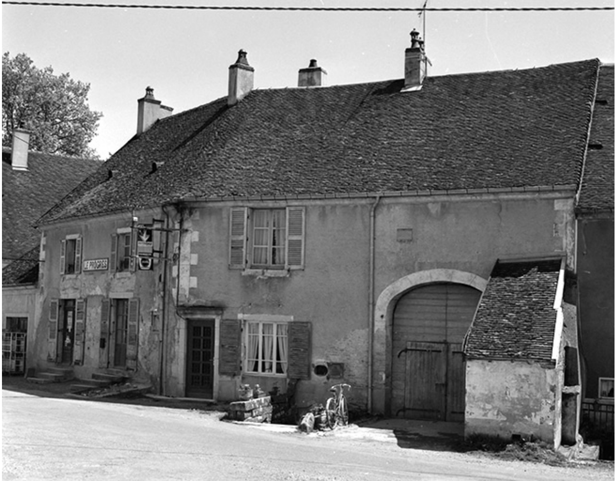
Ferme cadastrée AI 29-30 : façade antérieure, vue rapprochée.
