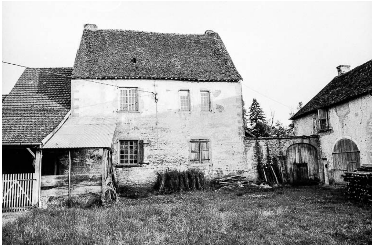
Ferme cadastrée 1960 AI 76 : façade postérieure.
