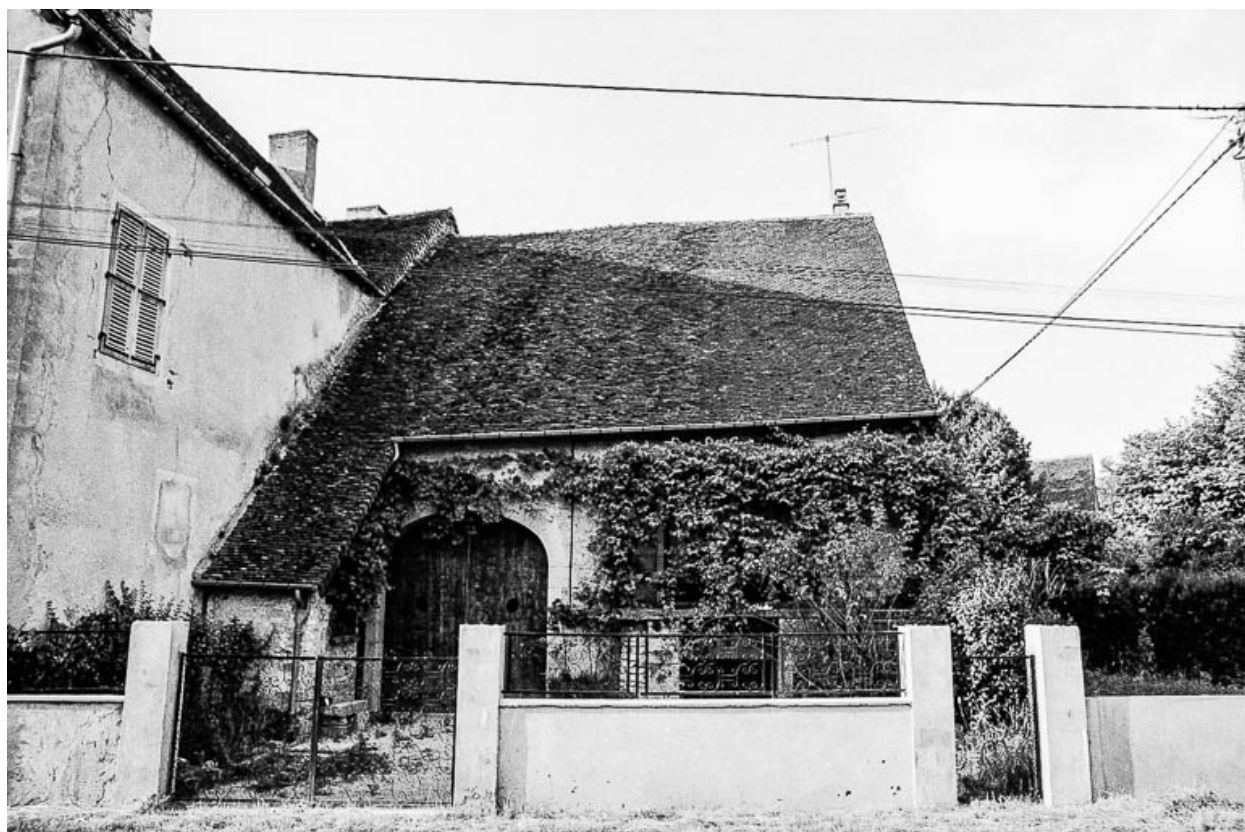
Maison située 75 rue du Général Lecourbe : façade antérieure.
