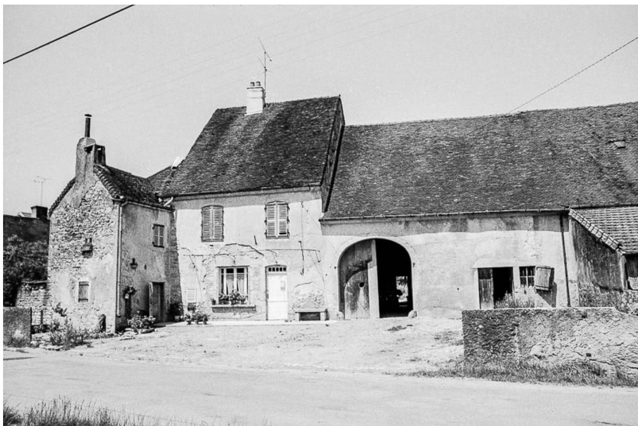
Ferme située rue d'Oisenans : façade antérieure.
