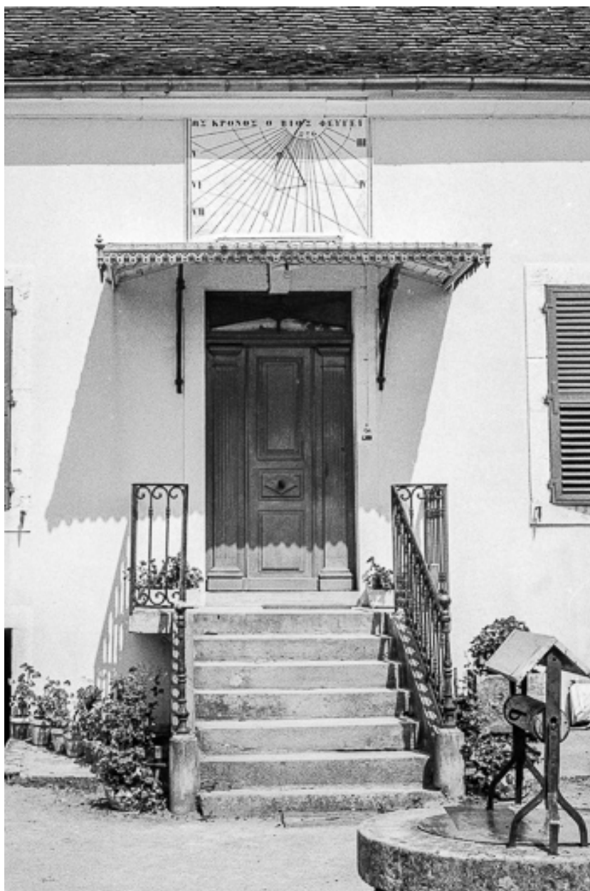
Ferme cadastrée 1960 AE 164, située rue Saint-Christophe : porte d'entrée de l'habitation.
