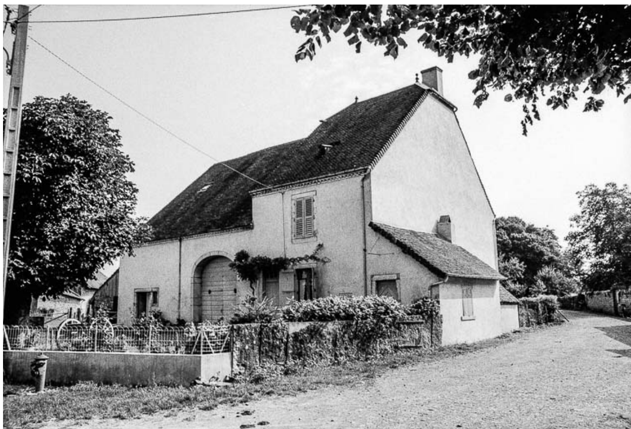
Ferme cadastrée 1960 AE 116, située rue Saint-Aignan : façades antérieure et latérale droite.
