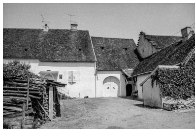
Ferme cadastrée 1960 AE 165, située rue Saint- Christophe : façade antérieure. Phot. Bernard Pontefract IVR43_19753900406Z
