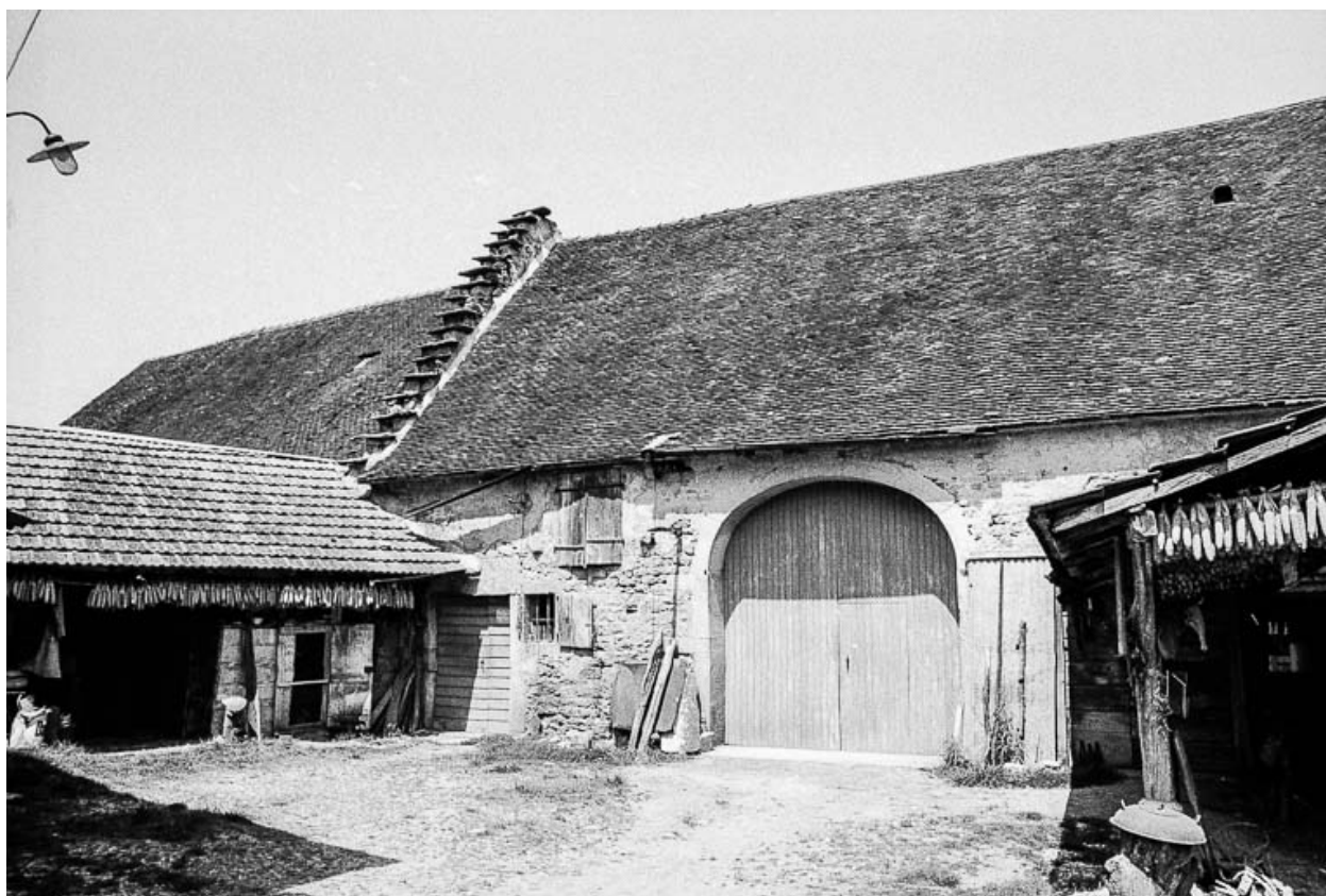
Fermes situées 324-326 rue d'Oisenans : bâtiments d'exploitation.
