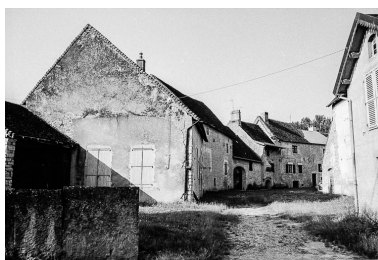
Maisons cadastrées 1960 AI 97 à 101, situées rue du Puits : vue d'ensemble. Phot. Bernard Pontefract IVR43_19753900426Z
