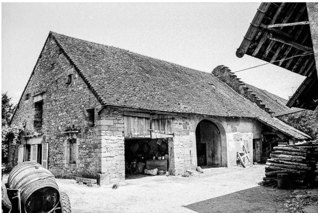
Ferme située 324-326 rue d'Oisenans : bâtiments d'exploitation.
