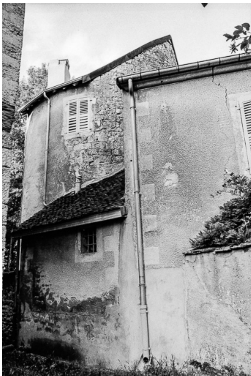
Ferme cadastrée 1960 AI 90, rue du Général Lecourbe : vestiges de tour.
