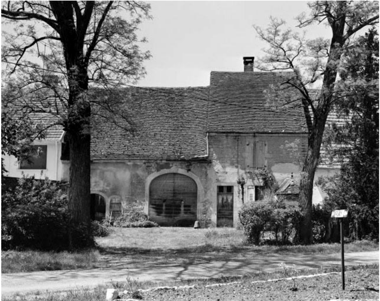
Ferme située rue du Raffour : façade antérieure.
