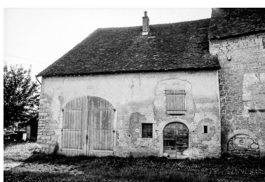
Maison cadastrée 1960 AI 101, située rue du Puits : façade antérieure.
