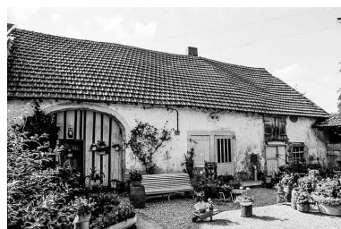
Maison cadastrée 1960 AR 105, située au lieu- dit Bard : façade antérieure. Phot. Bernard Pontefract IVR43_19753900451Z
