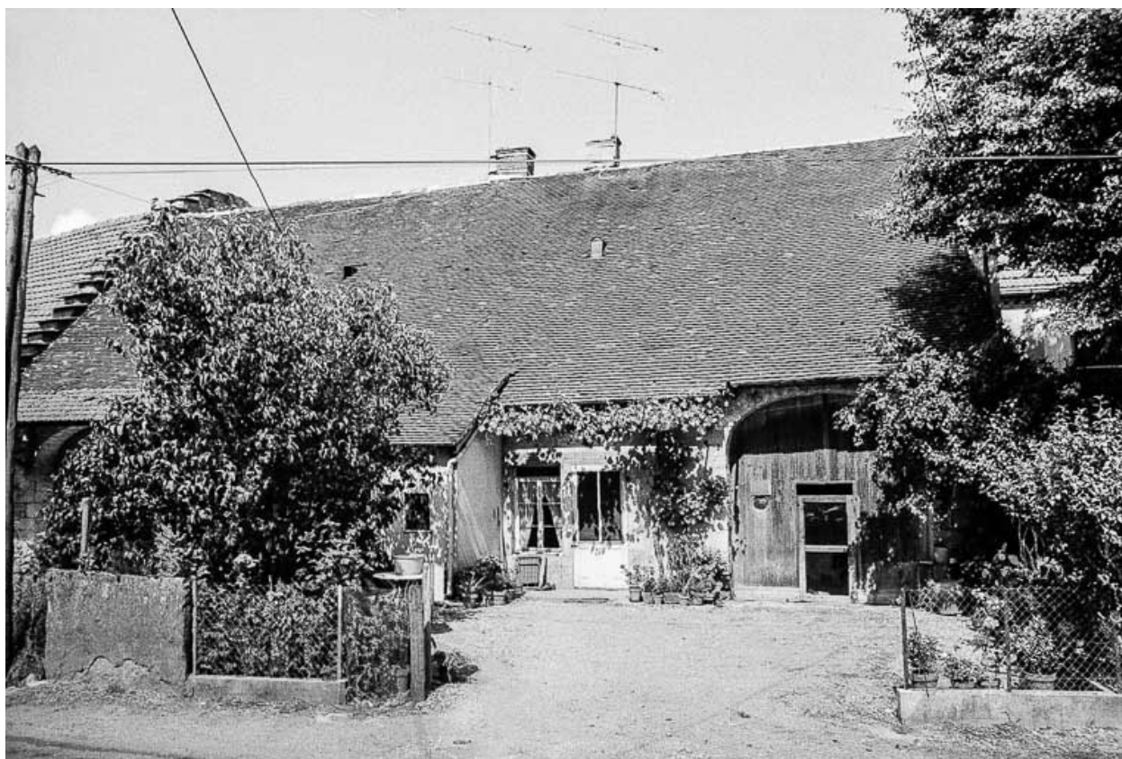
Ferme située 135 rue Général Gauthier : façade antérieure.
