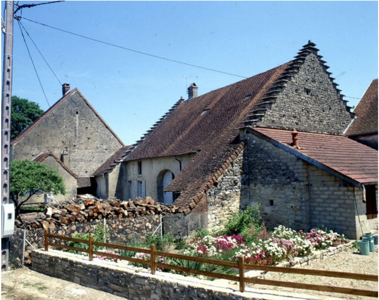
Ferme : façades latérale droite et antérieure.
