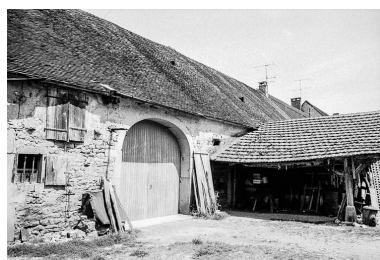
Fermes situées 324-326 rue d'Oisenans : bâtiments d'exploitation. Phot. Bernard Pontefract IVR43_19753900444Z
