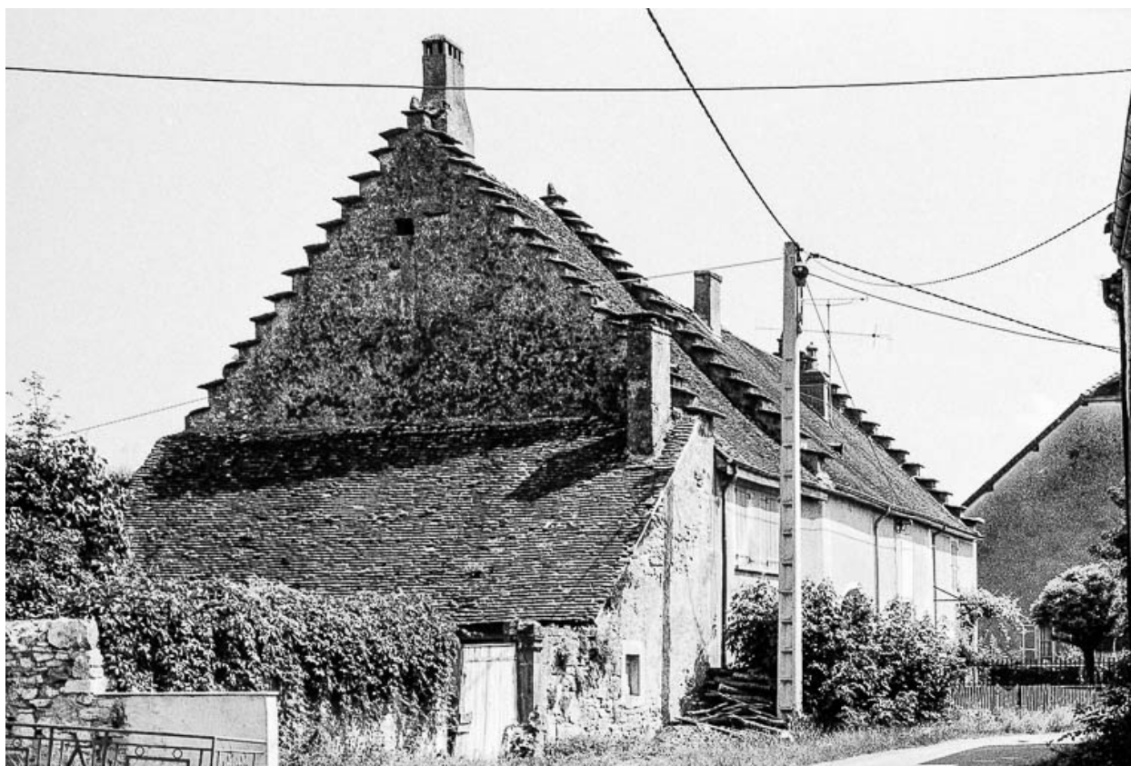
Maisons situées rue Saint-Christophe : vue de trois-quarts gauche.
