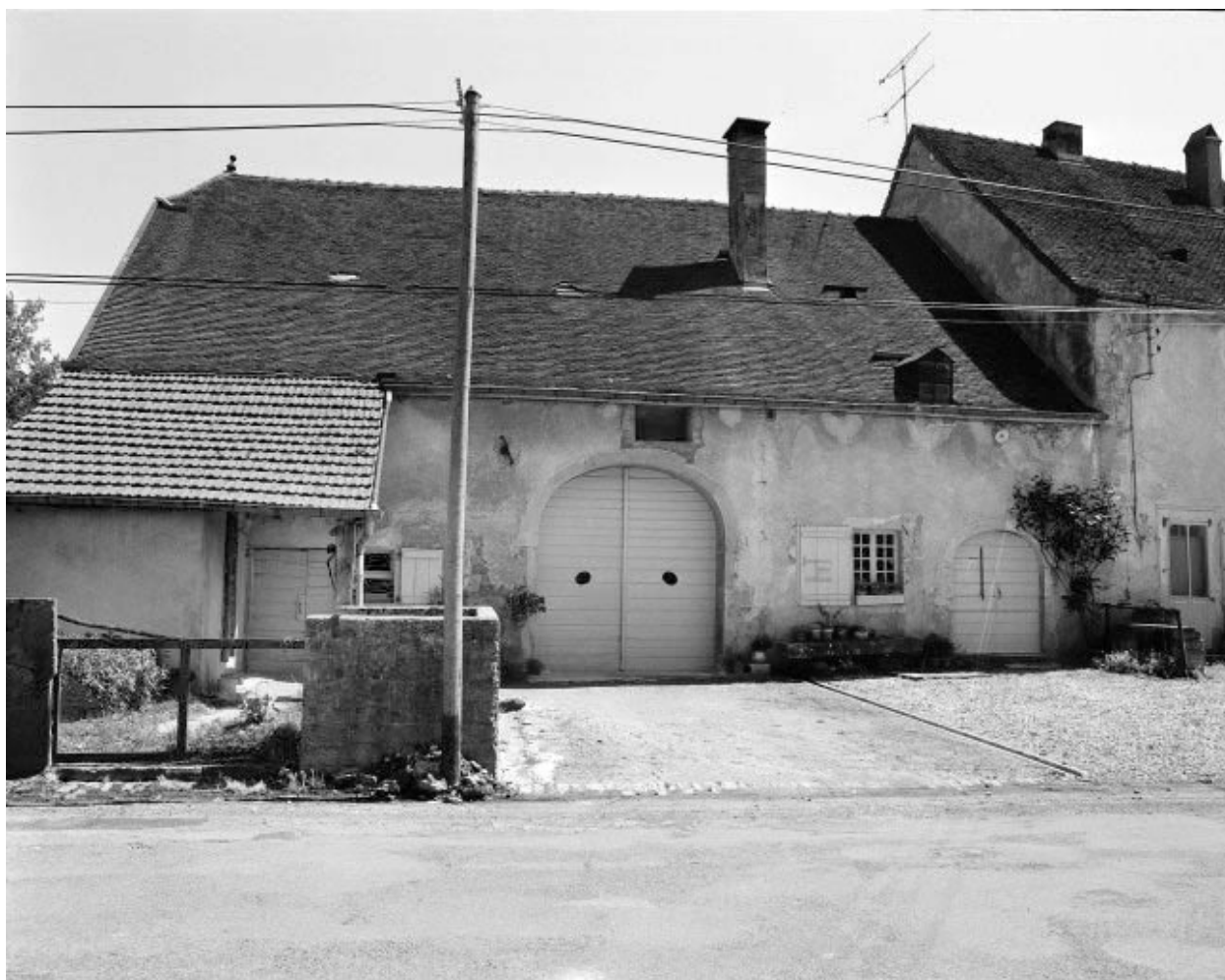
Ferme située rue d'Oisenans : façade antérieure.
