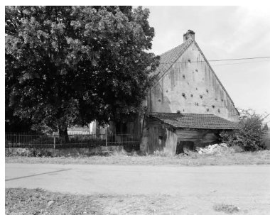
Ferme située rue Saint- Aignan : vue d'ensemble. Phot. Bernard Lardière IVR43_19793900337X
