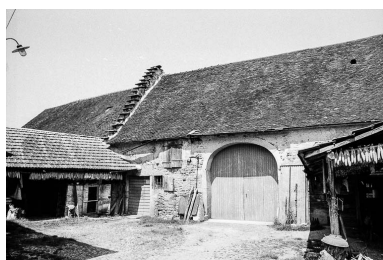
Fermes situées 324-326 rue d'Oisenans : bâtiments d'exploitation. Phot. Bernard Pontefract IVR43_19753900443Z
