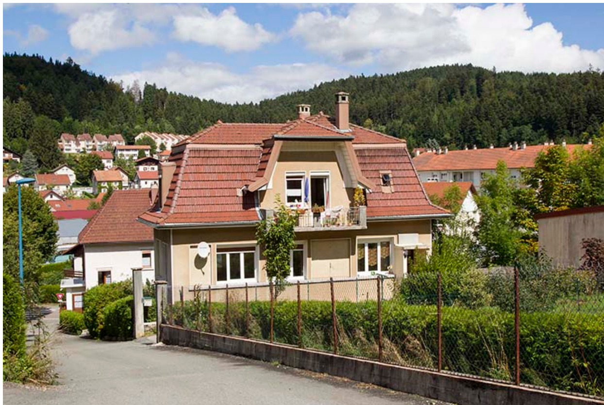
Façades postérieure et latérale droite.
