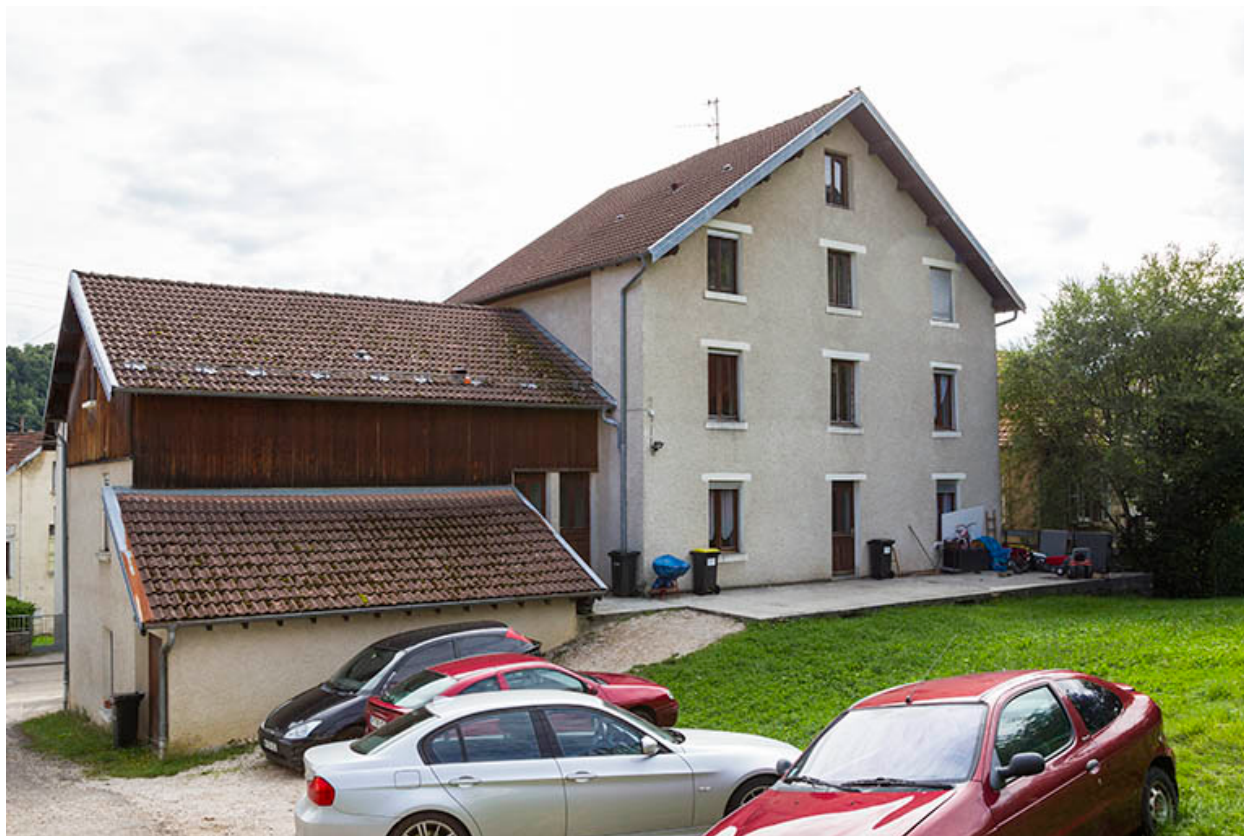
Façades postérieure et latérale droite.
