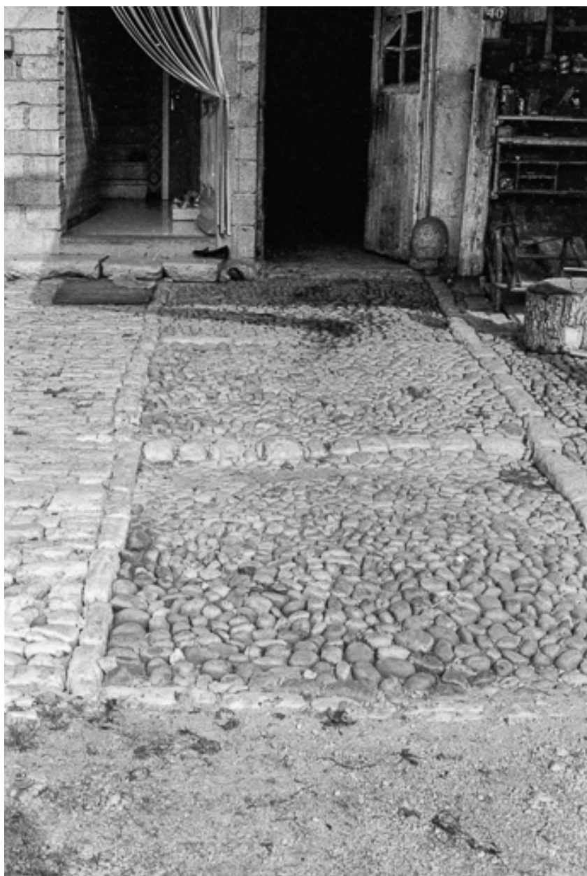
Ferme située à Bulle : entrée pavée , allée centrale destinée aux chevaux.
