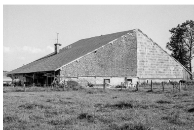
Ferme situé à Boujailles : pignon essenté de "tavaillons" (petit bardage cloué remplacé pour moitié par de la tôle). Phot. Gilbert Poinot IVR43_19752500780Z
