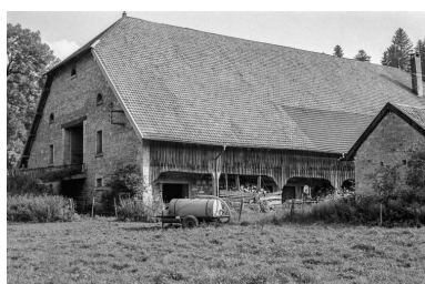
Ferme située à Levier : montée de grange haute sur pignon et fermeture d'avant-toit sur long-pan. Phot. Gilbert Poinot IVR43_19752501325Z
