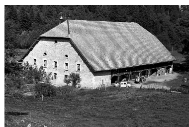
Ferme située à Levier dont le rez-de-chaussée est occupé par les étables - excepté l'habitation - avec grange haute. Phot. Bernard Lardière IVR43_19782500335X
