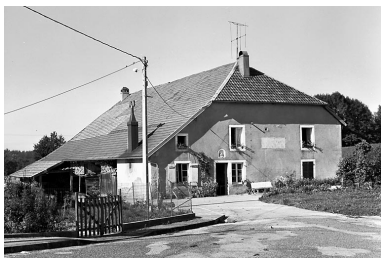
Arc-sous-Montenot : ferme située rue du Bois Brûlé. Phot. Bernard Lardière IVR43_19782500295X
