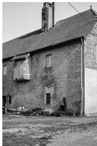
Ferme située à Villeneuve d'Amont : cul-du-four extérieur suspendu. Phot. Gilbert Poinot IVR43_19752501397Z
