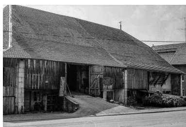
Ferme située à Evillers : murs à long-pan sur rue. Phot. Gilbert Poinot IVR43_19752501238Z
