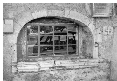
Ferme située à Sombacour : fenêtre de l'écurie et petite mangeoire à chevaux extérieure. Phot. Gilbert Poinot IVR43_19752501466Z
