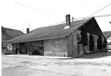
Ferme située à Evillers : pignon d'habitation et gouttereau sur rue. Phot. Bernard Lardière IVR43_19782500327X
