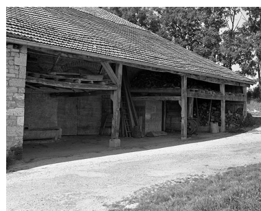
Ferme située à Septfontaines : auvent sur mur gouttereau et entrée de grange appareillée. Phot. Bernard Lardière IVR43_19782500342X
