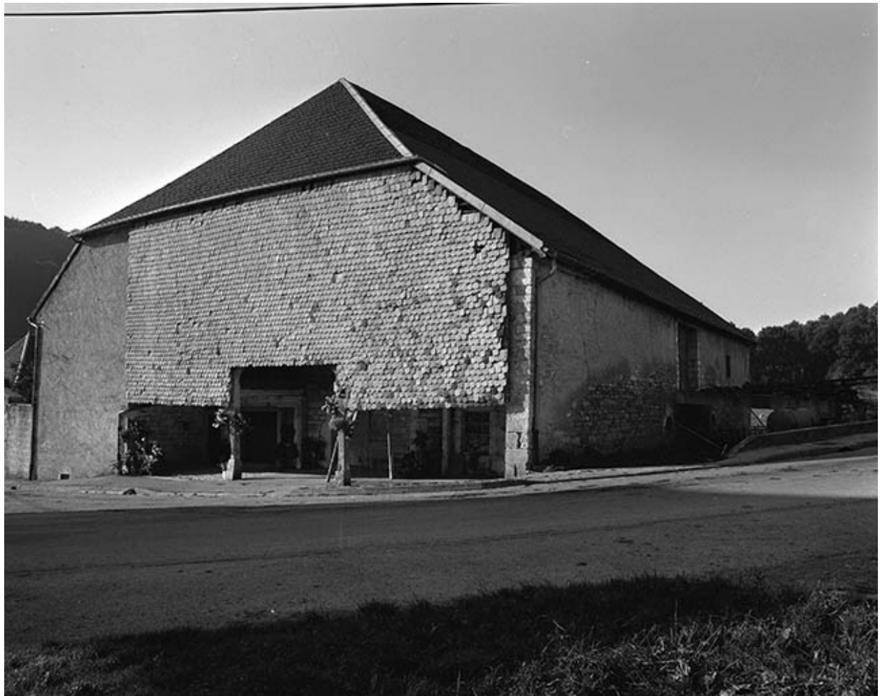
Ferme située à Chapelle d'Huin : exemple de ferme haute à habitation sur long-pan, fermeture de l'auvent en petites tuiles.
