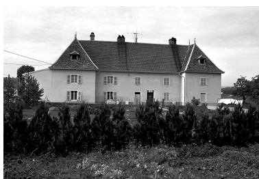
Ferme située à Sombacour : façade d'habitation d'une ferme classique du canton traitée en façade de château. Phot. Bernard Lardière IVR43_19782500348X
