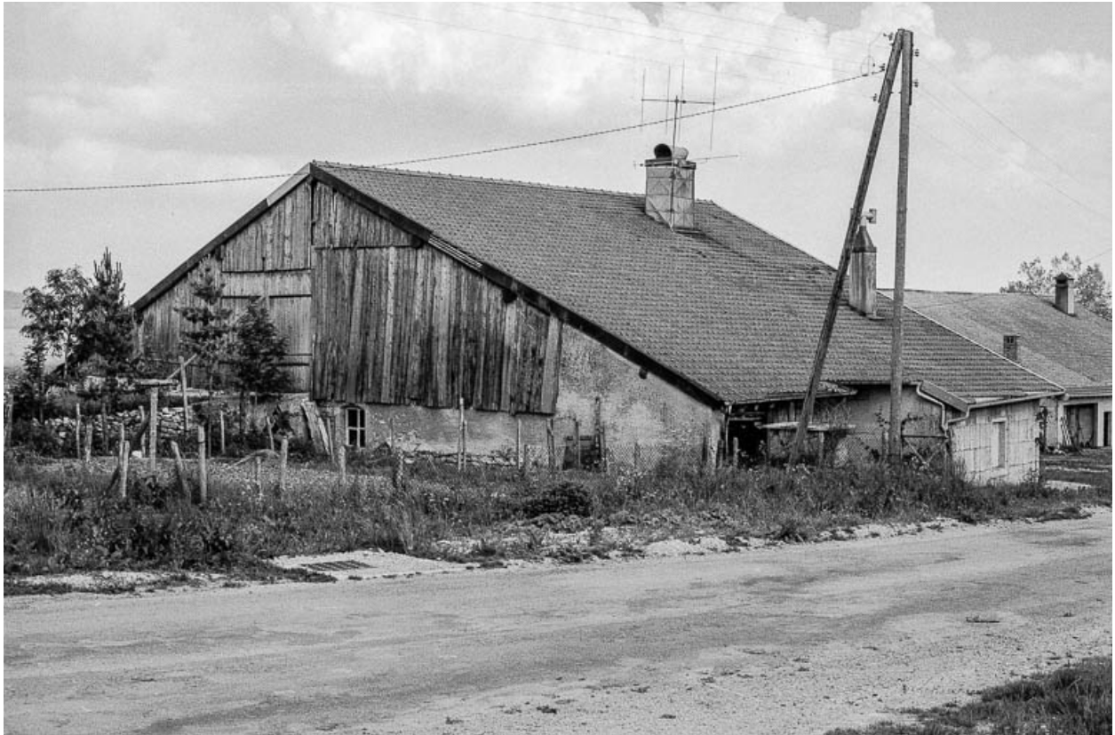
Ferme située à Boujailles : façades latérale et postérieure avec débord de la partie habitation, pignon fermé par des planches et montée de grange.
