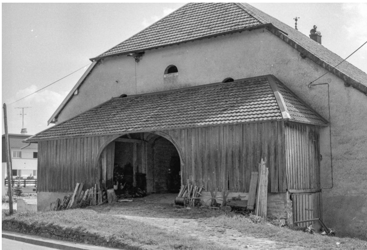
Ferme située à Evillers : entrée de la grange haute surmontée par une construction en bois.
