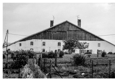
Ferme située à Frasne : pignon caractéristique des fermes du canton. Phot. Gilbert Poinot IVR43_19752500741Z
