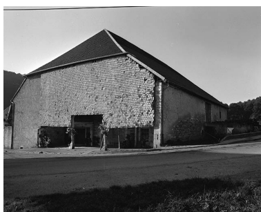
Ferme située à Chapelle d'Huin : exemple de ferme haute à habitation sur long-pan, fermeture de l'auvent en petites tuiles. Phot. Bernard Lardière IVR43_19782500311X
