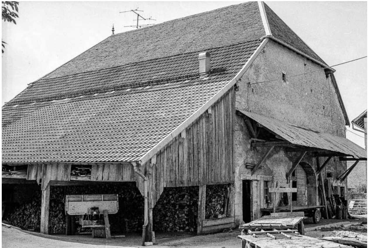
Ferme située à Evillers : ferme à travées de grange et d'écuries perpendiculaires à la travée d'habitation sur pignon.
