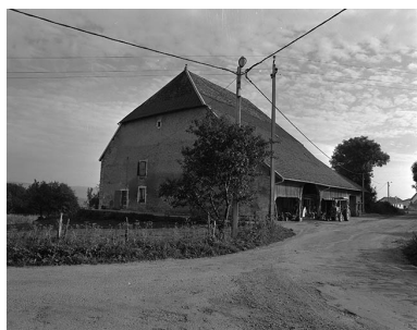
Ferme située à Frasne : habitation sur long-pan. Phot. Bernard Lardière IVR43_19782500328X
