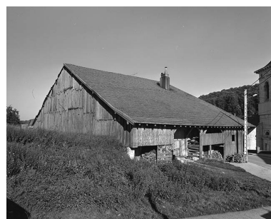
Chapelle d'Huin : ferme avec débord de toit permettant de mettre à l'abri le bois, pignon postérieur fermé par des planches du fait de la pente. Phot. Bernard Lardière IVR43_19782500310X
