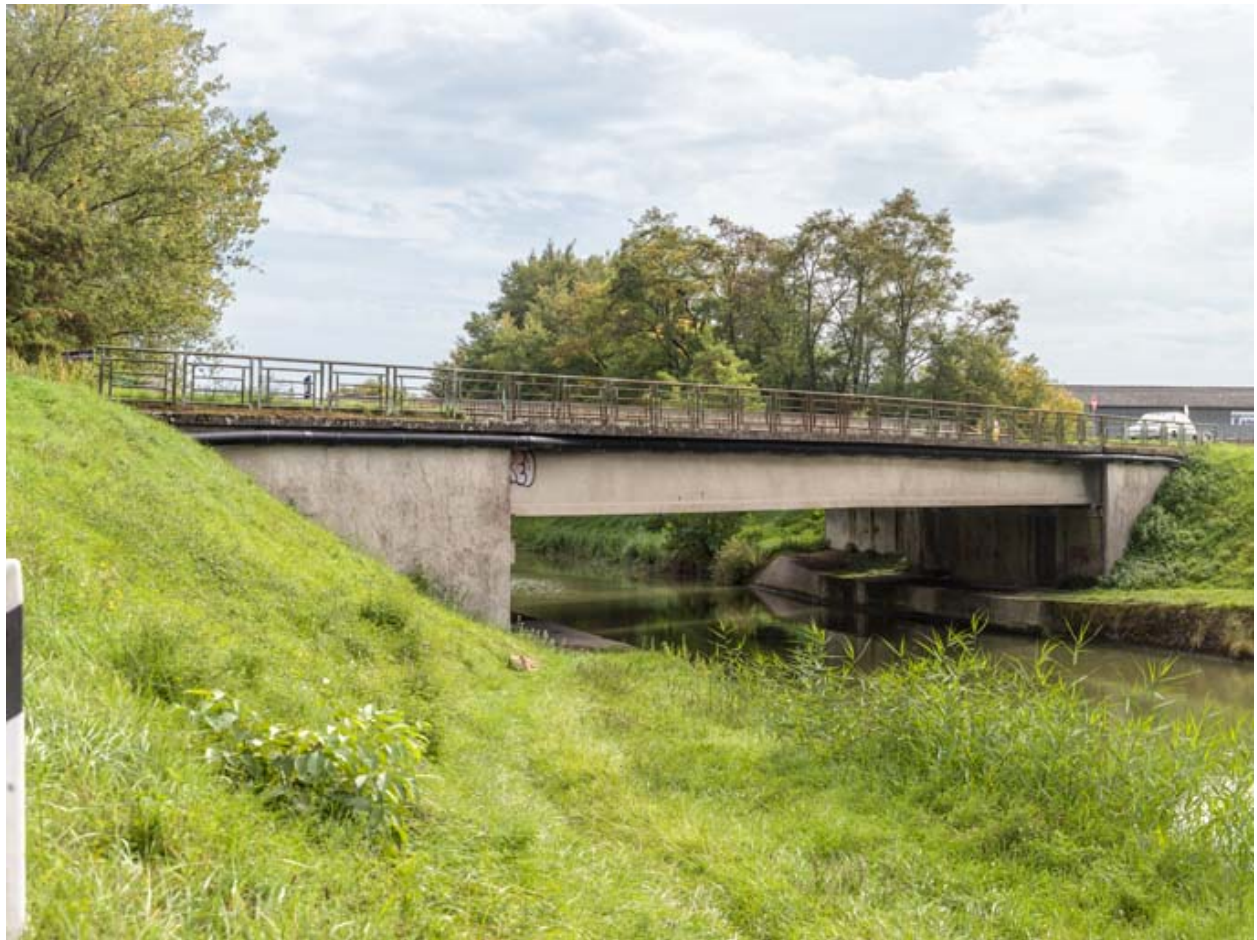
Vue d'ensemble du pont.
