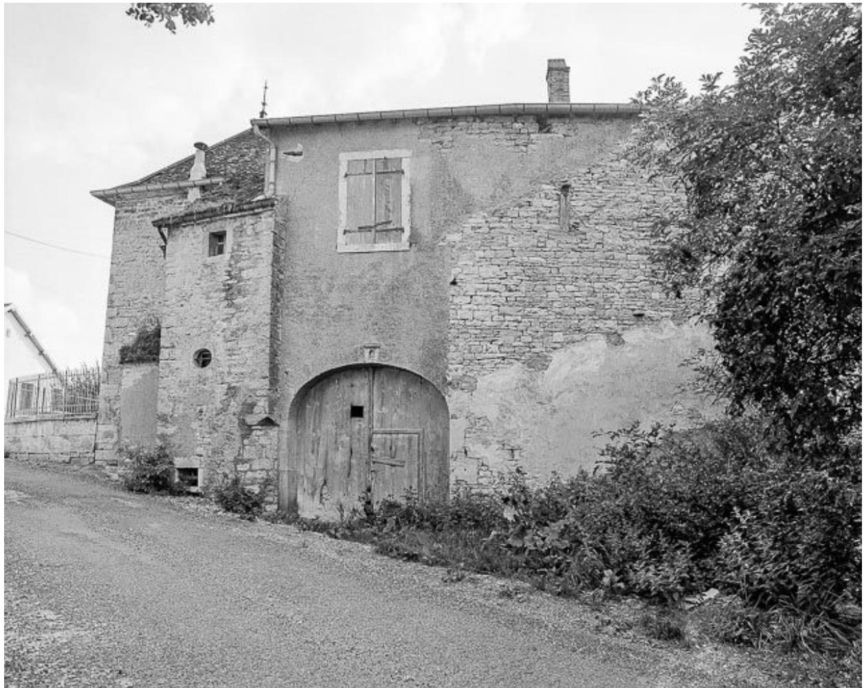
Vue rapprochée de la façade latérale droite.
