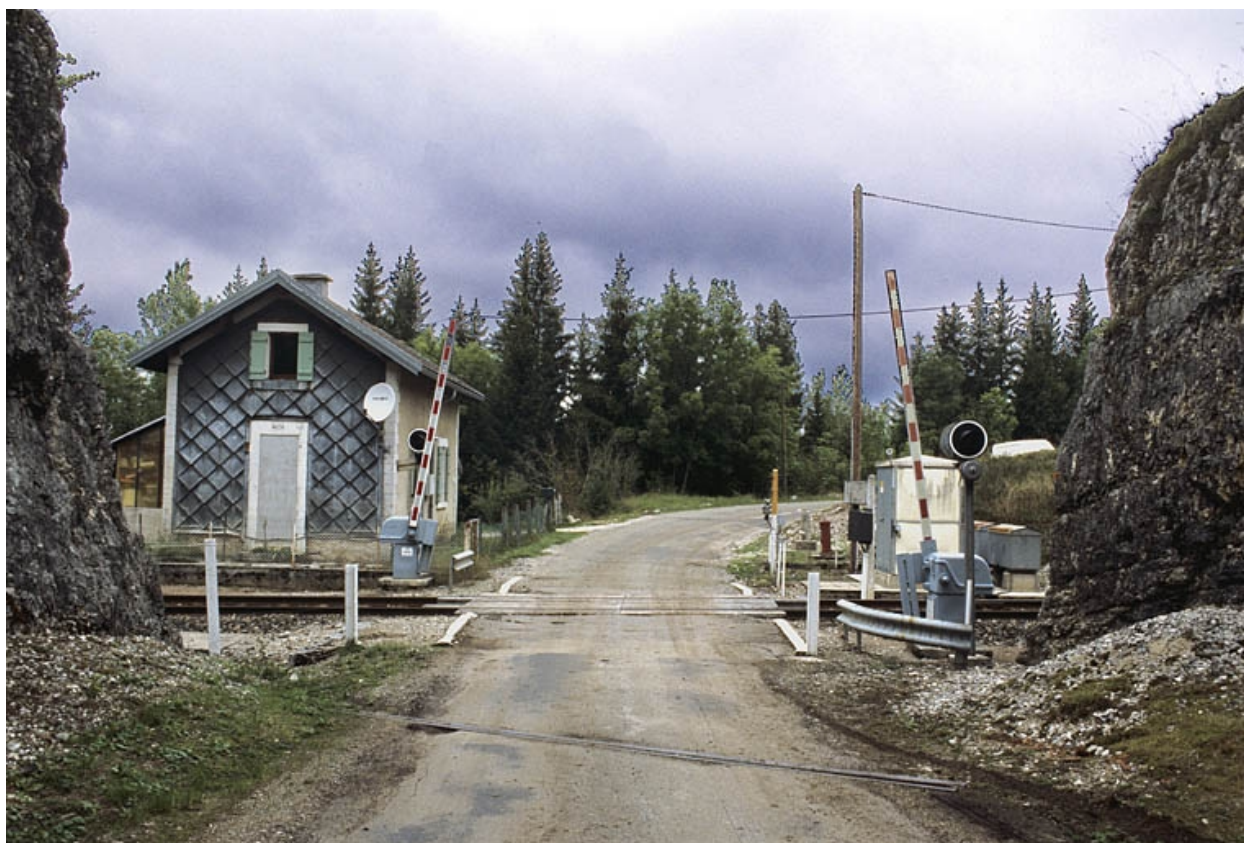
Façade sud (côté voie).
