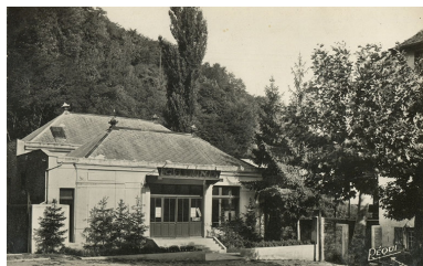
Vue extérieure. Phot. auteur inconnu IVR43_20223900064NUC4A
