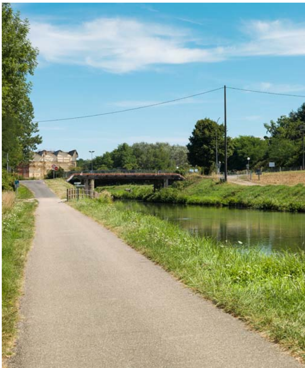
Vue d'ensemble du pont.
