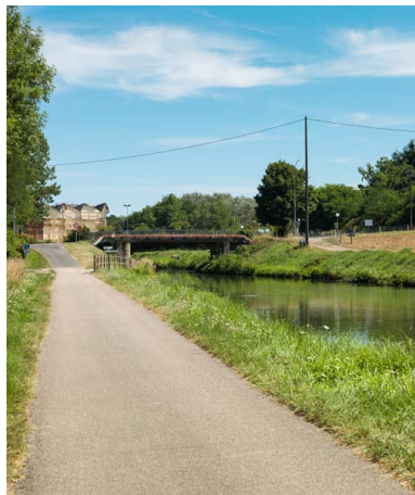
Vue d'ensemble du pont.
