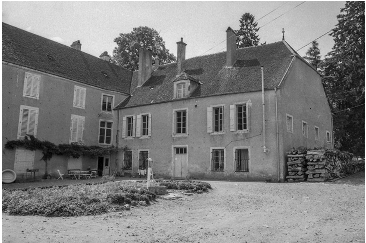
Vue de l'habitation depuis la cour.
