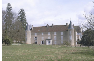
Façade sur parc. Phot. Yves Sancey IVR43_19857000072XA
