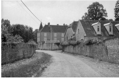
Vue d'ensemble depuis la rue. Phot. Bernard Lardière IVR43_19817000454Z
