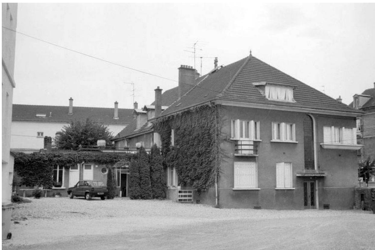
Logement patronal, vu depuis la cour.
