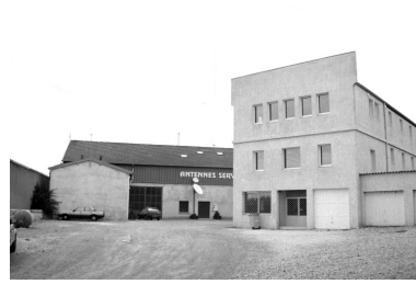
Vestiaire, magasin industriel et magasin à modèles. Phot. Laurent Poupard IVR43_19893900219Z
