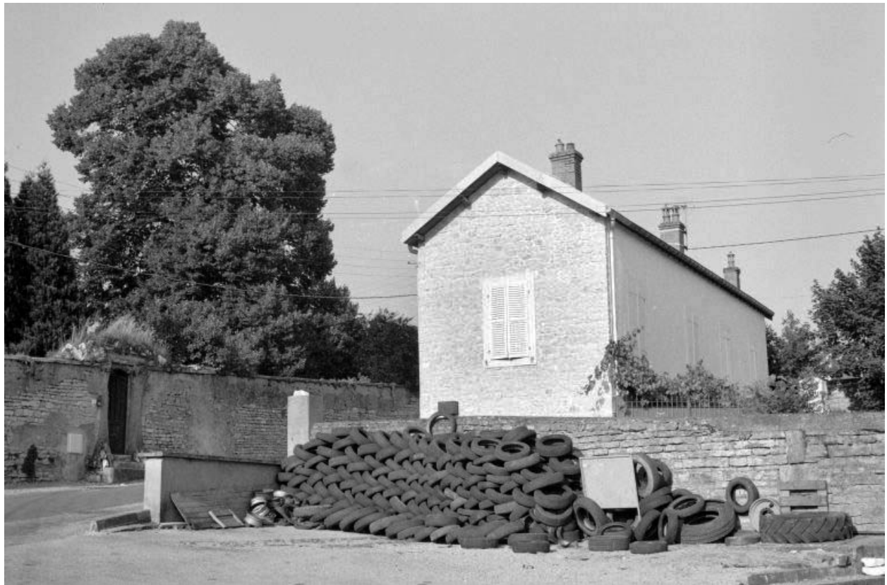
Logement de contremaître.
