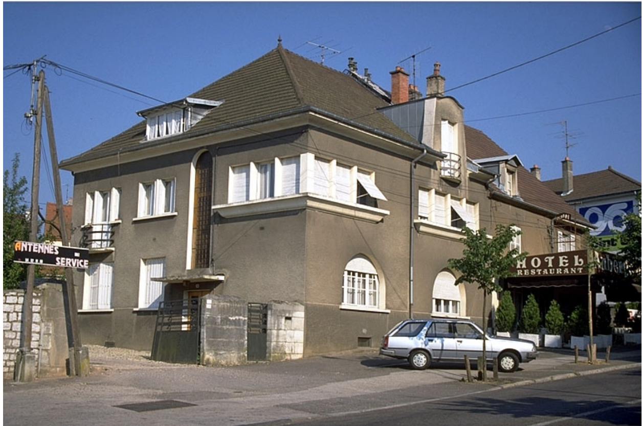
Logement patronal, vu depuis l'avenue.
