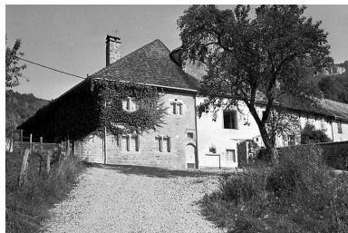
Vue générale. Phot. Yves Sancey IVR43_19802501079X
