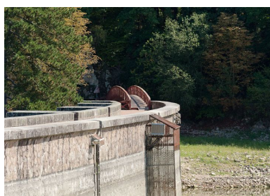
Vue de la digue du réservoir. Phot. Pierre-Marie Barbe-Richaud IVR26_20112103622NUC4AQ
