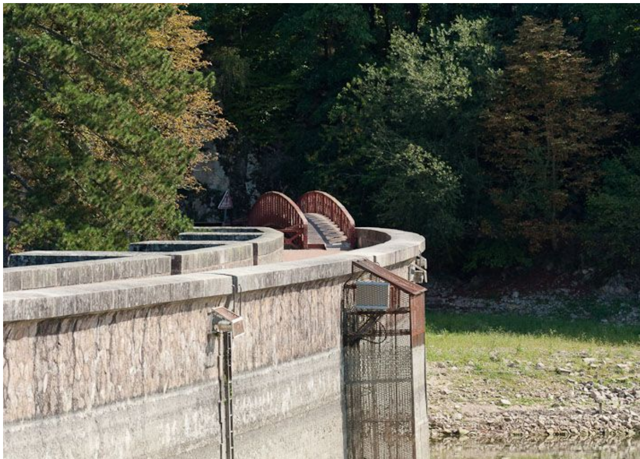
Vue de la digue du réservoir.
