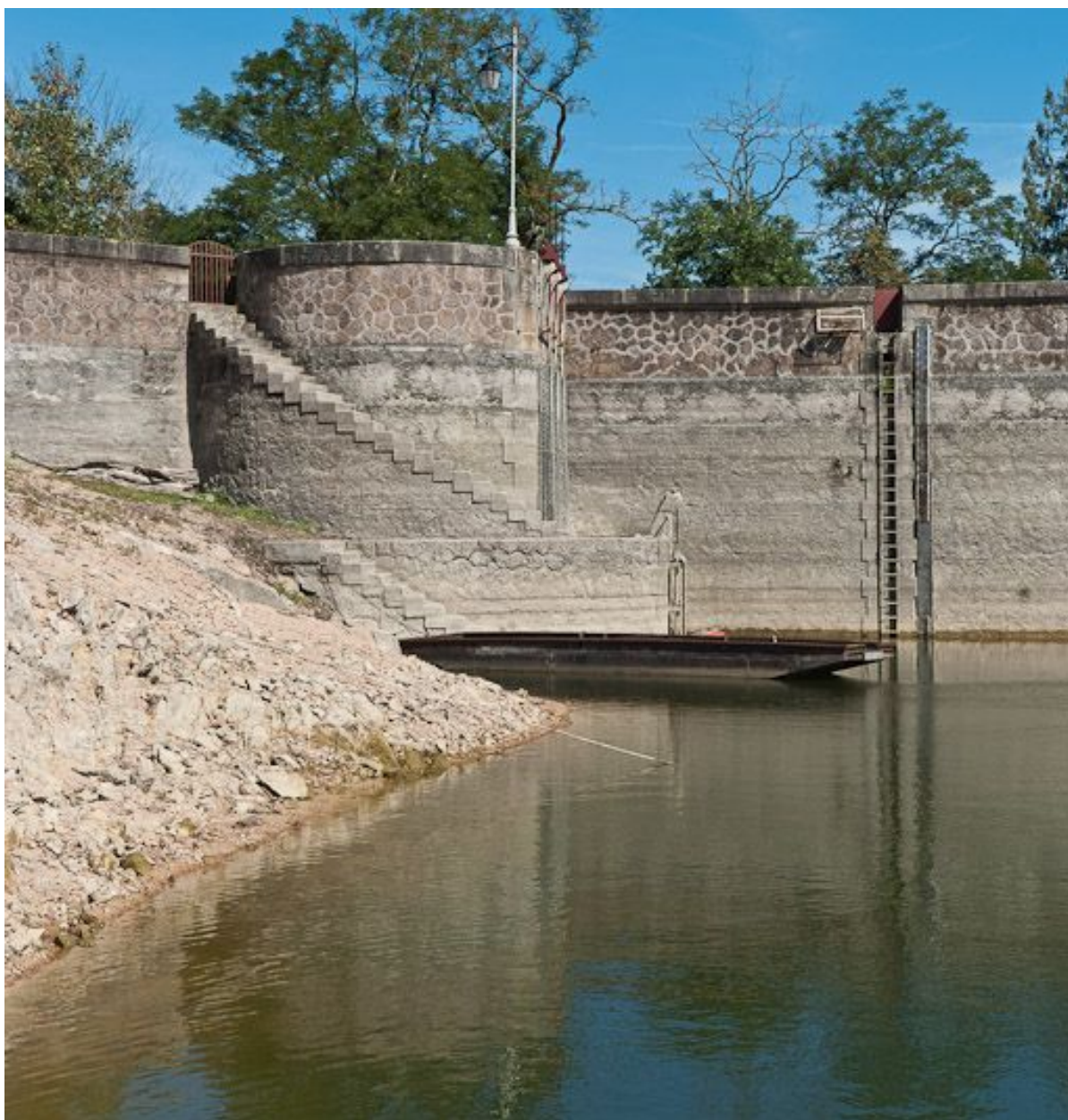
Vue de la tour de prise d'eau.
