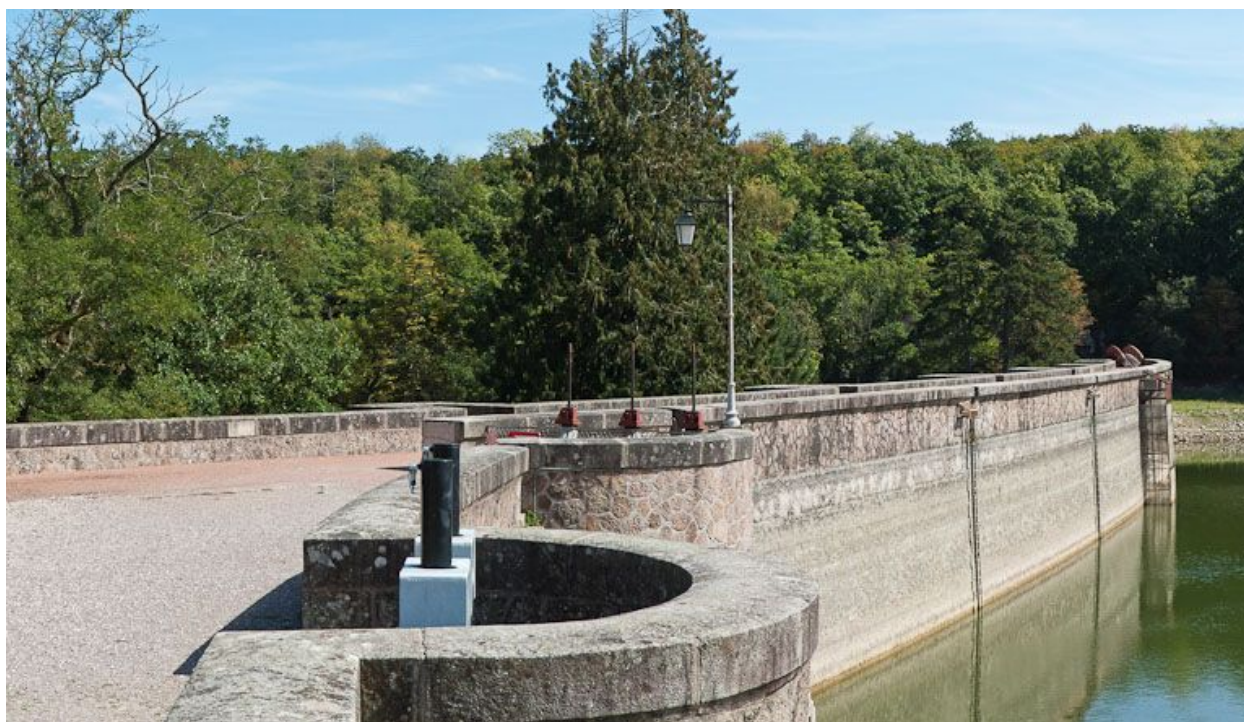
Vue de la digue du réservoir.
