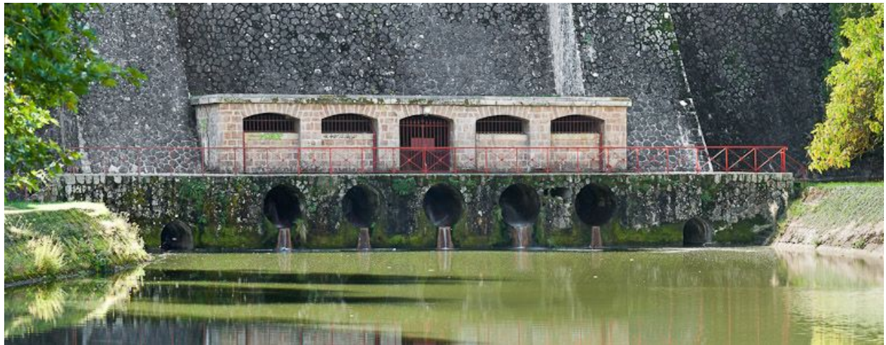
Vue extérieure de la chambre des robinets située en contrebas de la digue.
