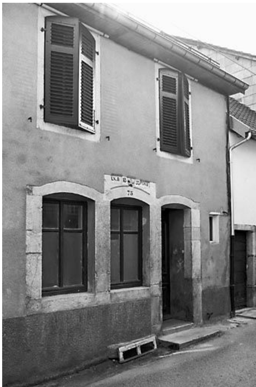
Façade antérieure vue de trois quarts gauche.
