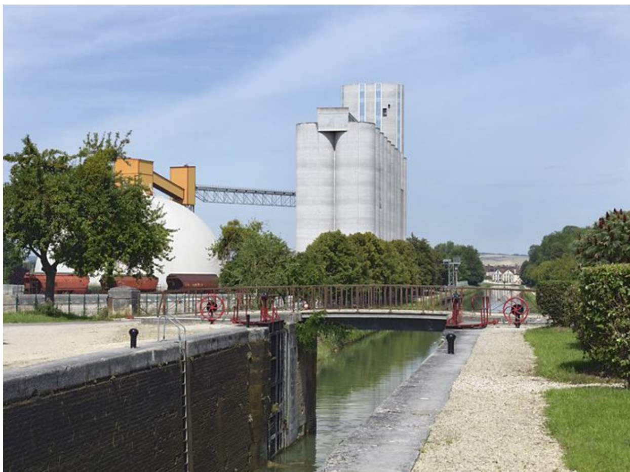
Pont vu d'amont. Silos en arrière-plan.
