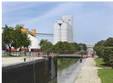
Pont vu d'amont. Silos en arrière-plan.
