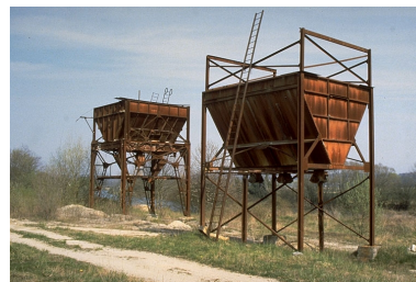
Trémies du poste de chargement. Phot. Laurent Poupard IVR43_19883900142ZA
