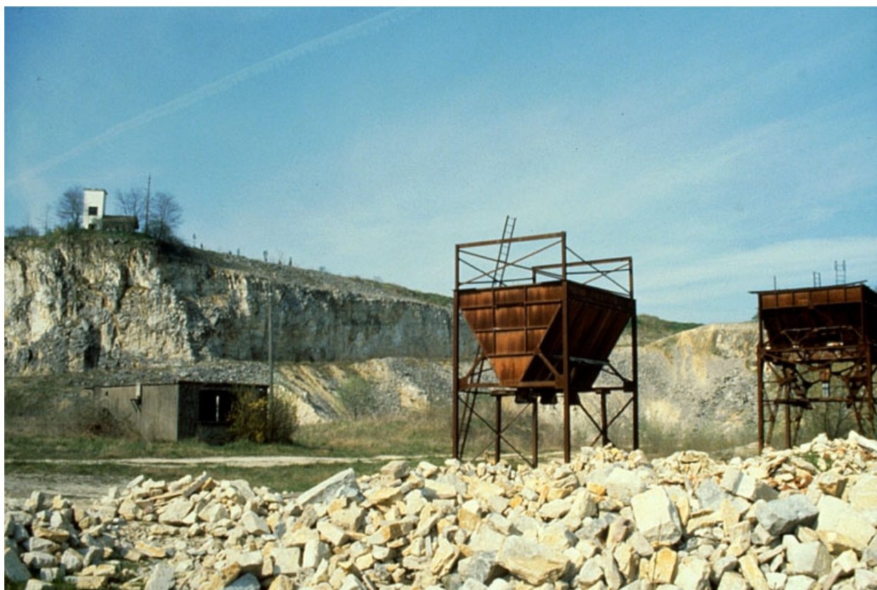
Transformateur, bureau et poste de chargement.
