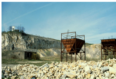
Transformateur, bureau et poste de chargement. Phot. Laurent Poupard IVR43_19883900141ZA
