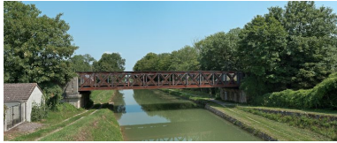
Vue du pont.
