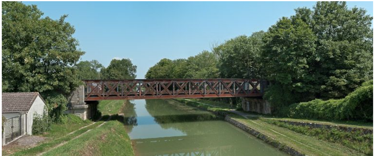
Vue du pont.
