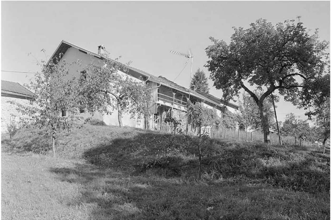
Vue d'ensemble de la façade postérieure.
