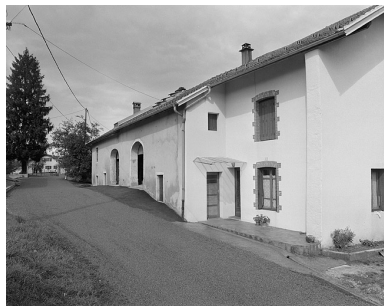
Façade sur la rue vue de trois quarts. Phot. Jérôme Mongreville IVR43_19963901042X
