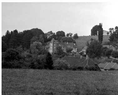
Demeure "Le Meix Quartier" située au lieudit Feschaux. Phot. Yves Sancey IVR43_19843900386X
