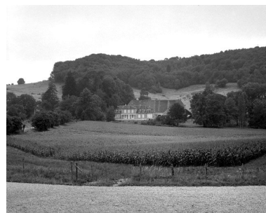
Demeure située au lieudit le Pré de la Canne. Phot. Yves Sancey IVR43_19843900366X
