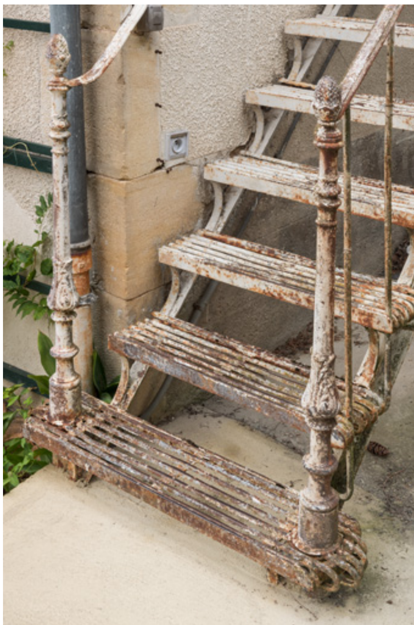
Escalier extérieur conduisant à l'étage, détail.
