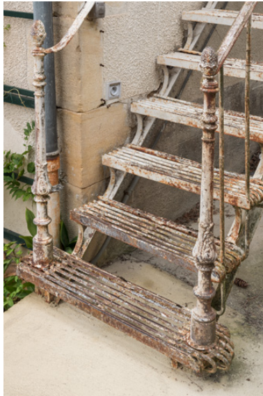
Escalier extérieur conduisant à l'étage, détail. Phot. Pierre-Marie Barbe-Richaud IVR26_20195800422NUC4A
