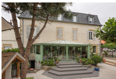
Façade côté jardin. Phot. Pierre-Marie Barbe-Richaud IVR26_20195800389NUC4A
