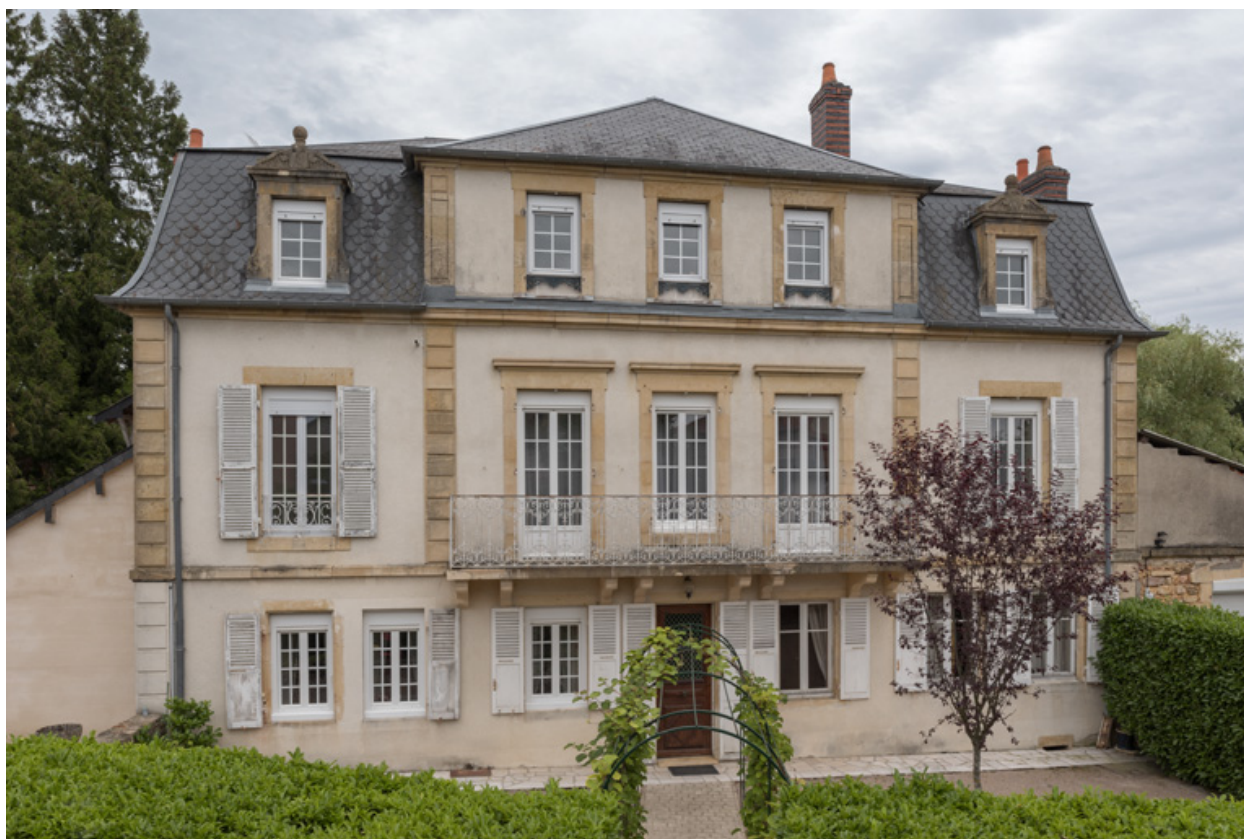
Façade côté rue.
