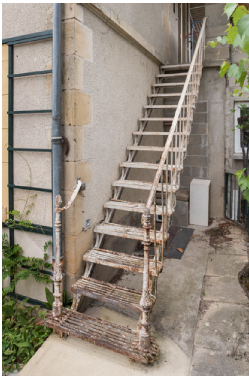
Escalier extérieur conduisant à l'étage.
