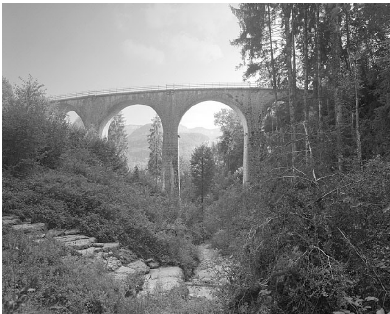
Le viaduc depuis le ruisseau du Nans.
