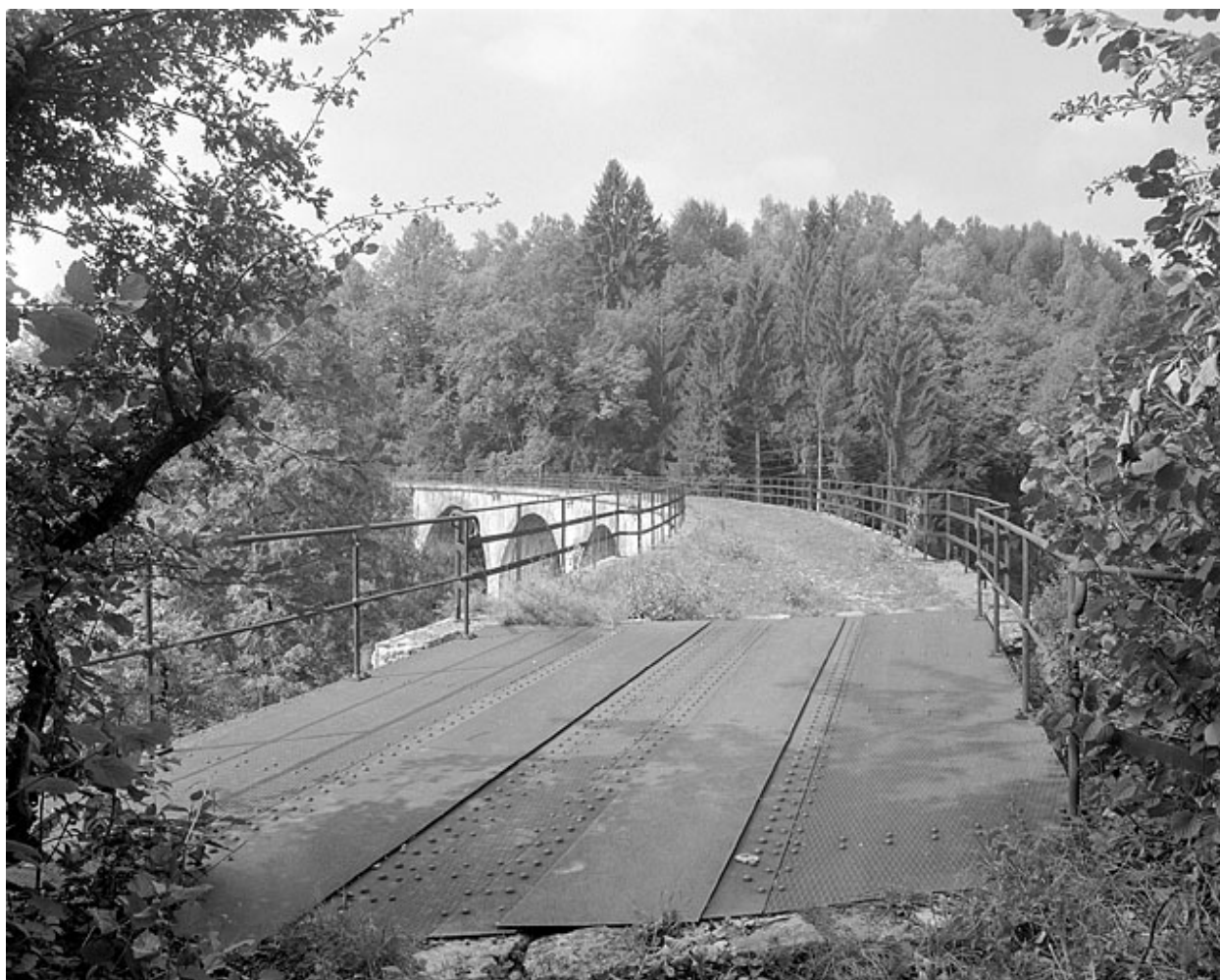
Tablier du viaduc.
