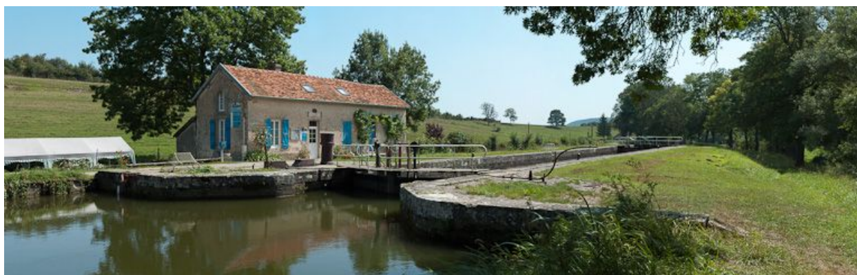
Vue du site d'écluse.
