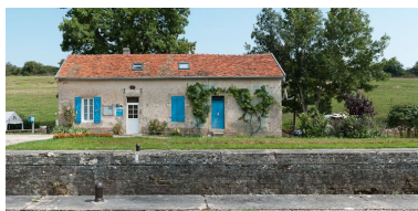
Vue de face de la maison éclusière.
