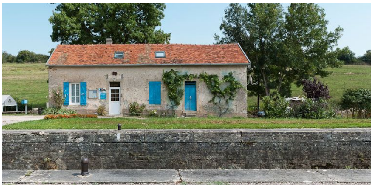
Vue de face de la maison éclusière.
