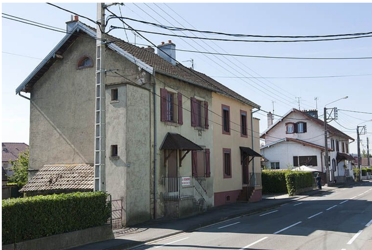
Deux habitations de 4 logements rue des Mines.
