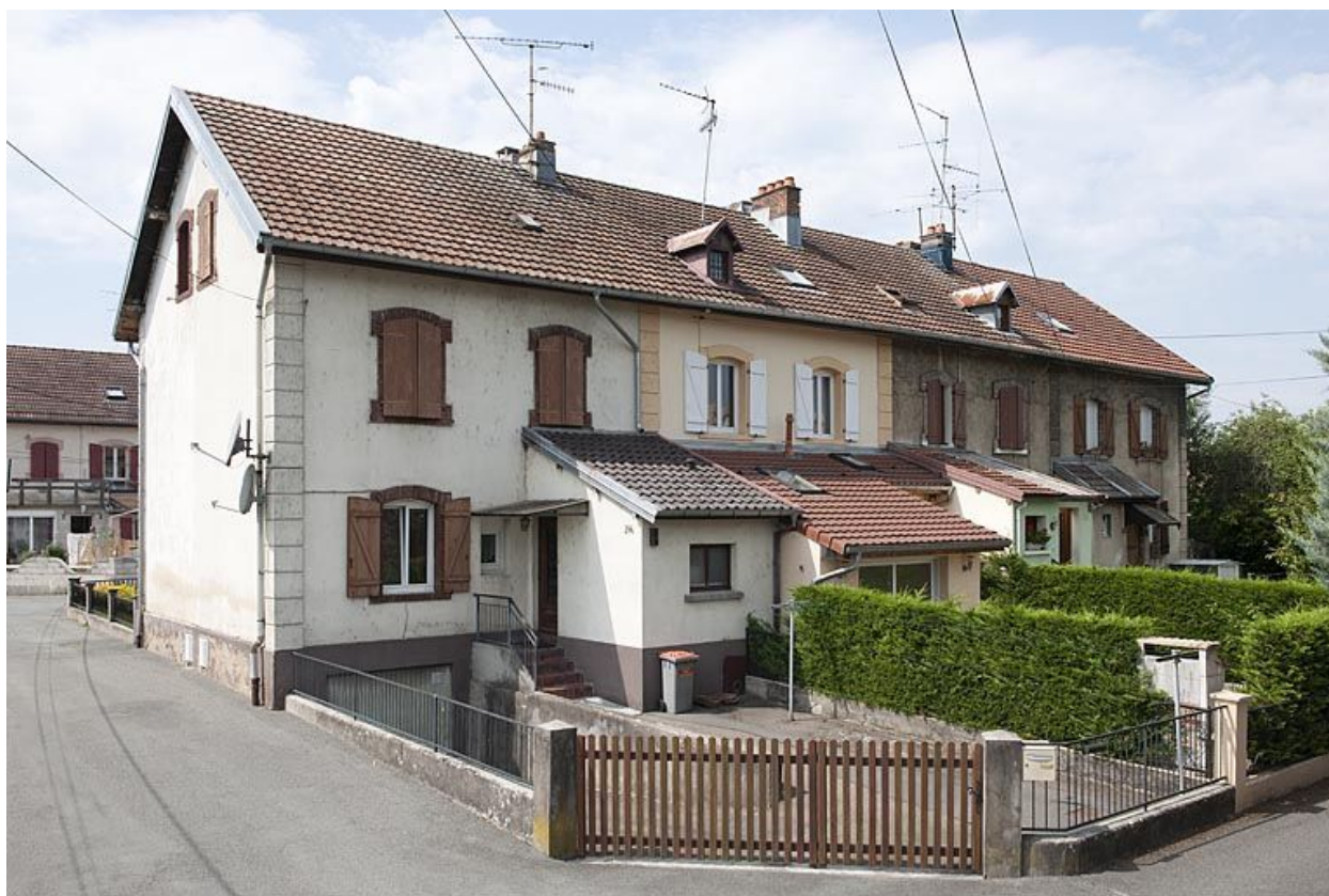
Habitation à 8 logements vue de trois quarts.
