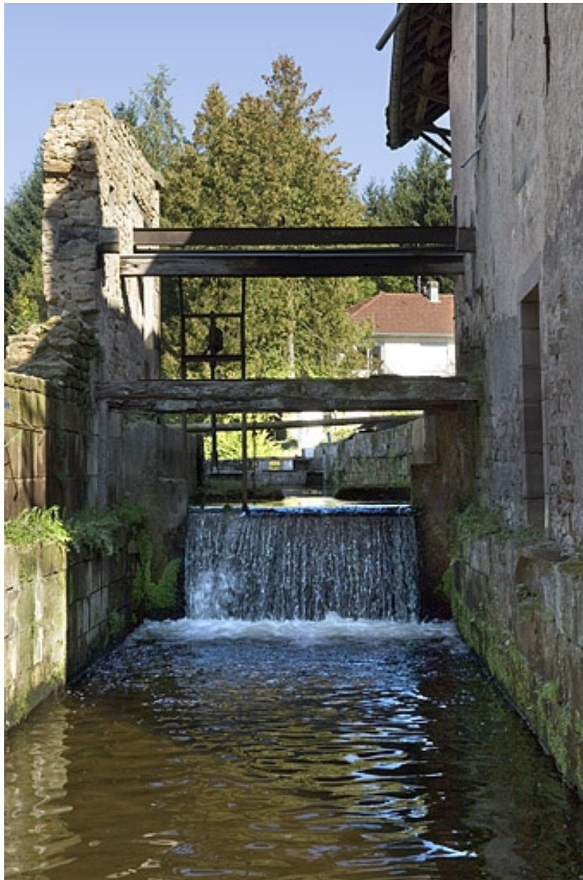
Bief de dérivation depuis l'aval.
